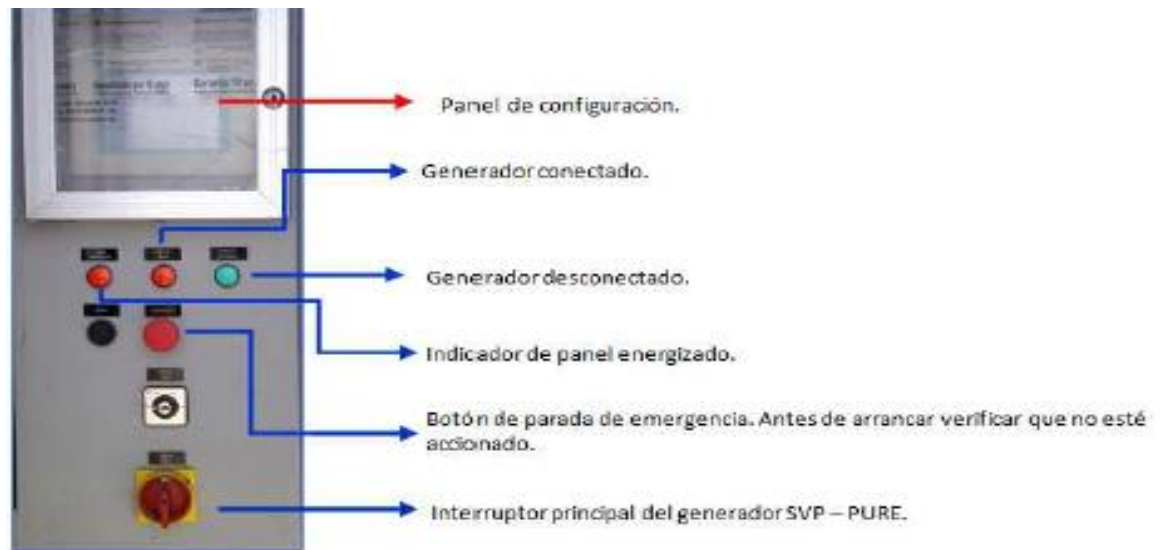
Figura 23. Panel de control del generador utilizado en la prueba de campo.
