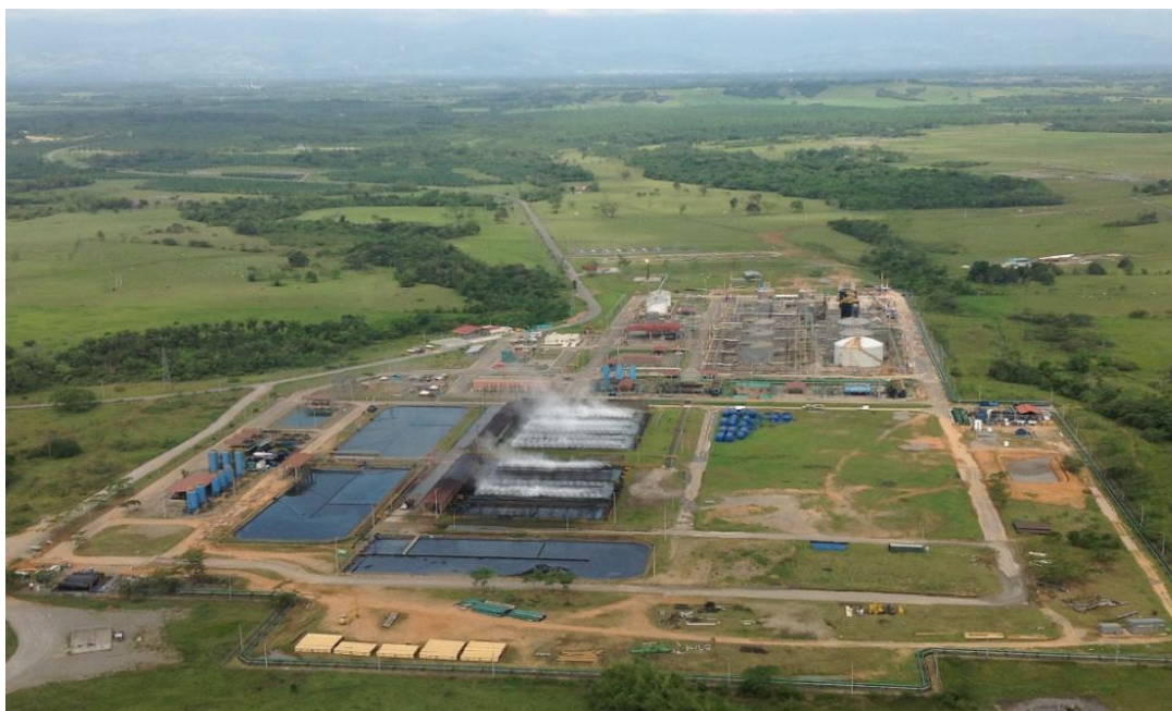
Figura 3. Panorámica estación Acacias 1.
