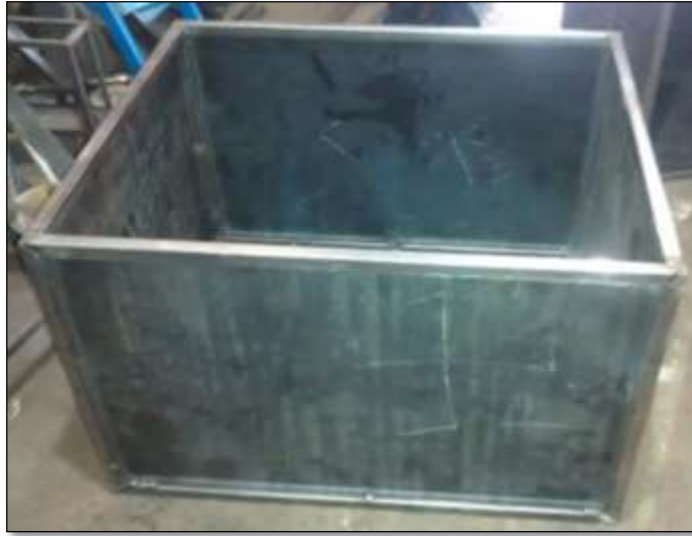
Figura 37. Avance en la construcción del bastidor
