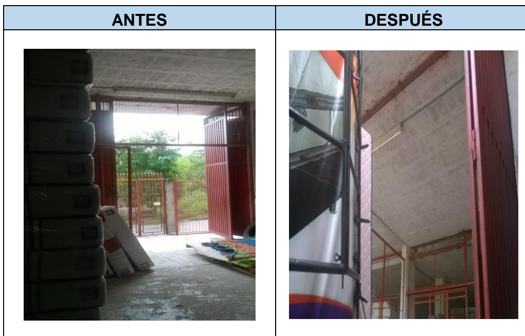
Ilustración 39. Antes y después eliminación de rejas jaula de alistamiento #2
