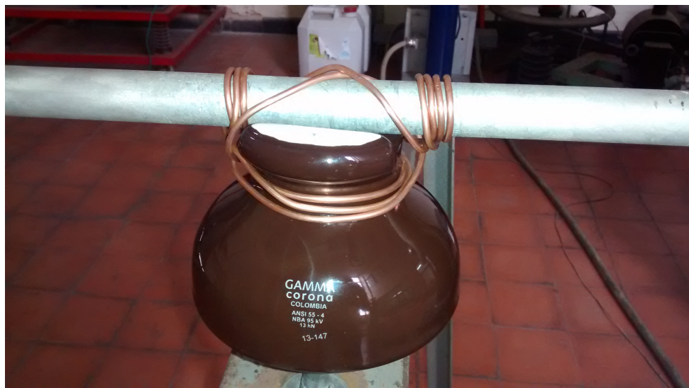
Figura 21: Objeto de prueba 1: sin daño.
