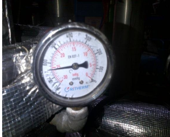
Figura 42. Lectura presión Vacuómetro.
