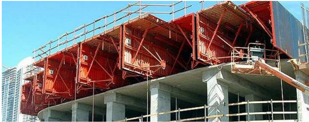
Figura 9. Formaleta en U invertida utilizada en el sistema tipo túnel.
