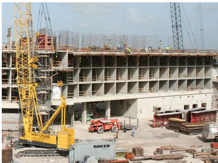
Figura 8. Edificación de muros estructurales sistema tipo túnel
