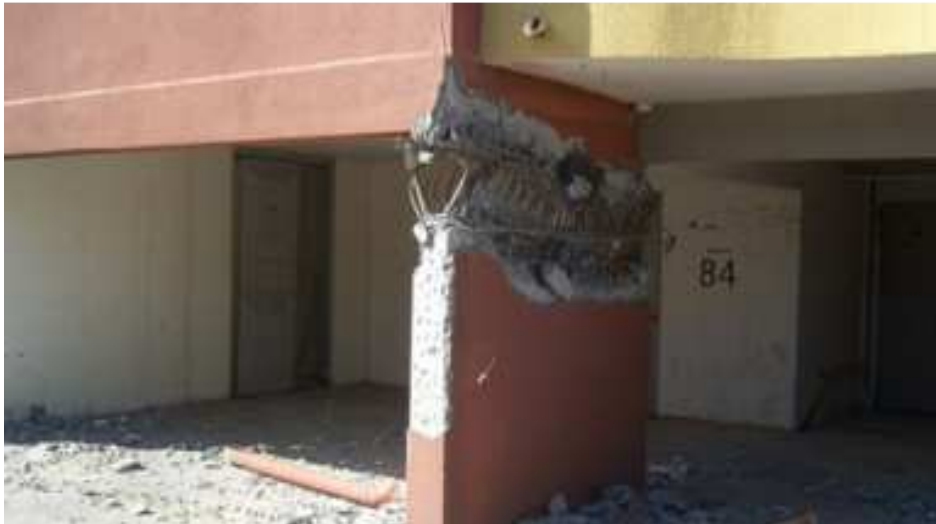
Figura 18. Falla típica a flexión por ausencia de confinamiento en sus elementos especiales de borde.
