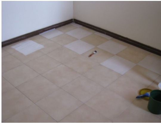
Figura 36. Transformación de habitación para secuencia 14.
