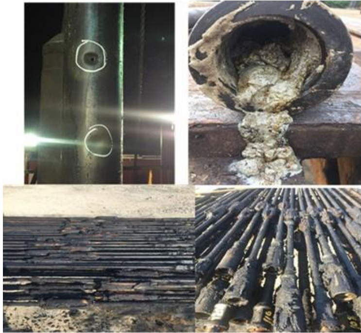
Figura 44. Evidencia de fallas Pozo B Febrero 2018.
