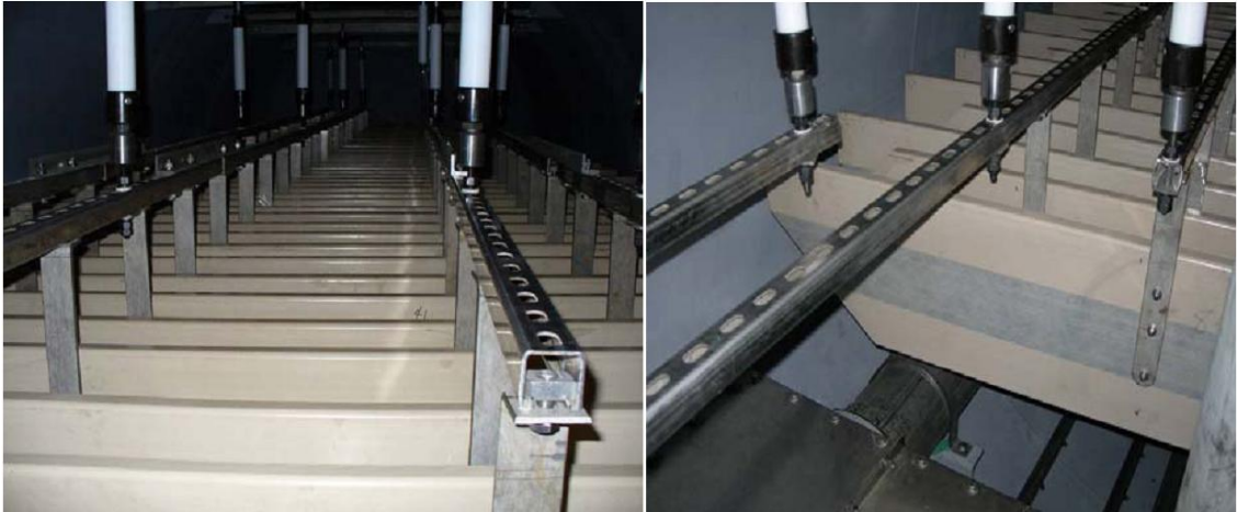
Figura 18. Detalle de la instalación de rejillas.
