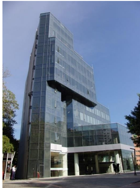
Figura 3. Instalaciones IBM Colombia sede Medellín
