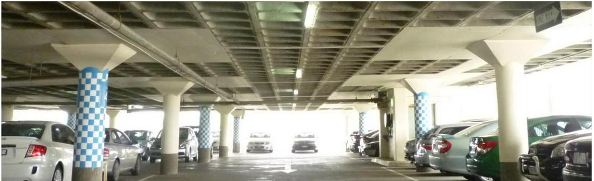
El capitel tetraédrico es un poco dispendioso de modelar en el software, sin embargo el análisis de esfuerzos puede ser confiable y fácilmente ejecutable mediante un chequeo del tipo puntal-tensor.
