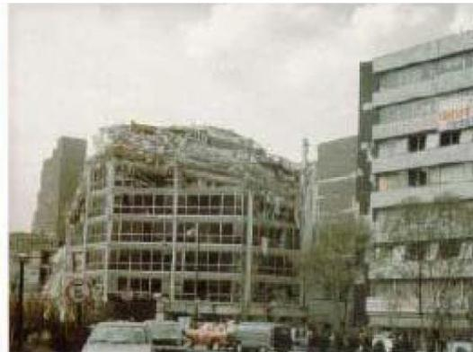
**El mecanismo de falla.** El mecanismo de falla del sistema reticular es simple, ante grandes deformaciones la interacción o lucha entre la columna y el capitel, produce que la columna penetre el capitel en una falla típica por punzonamiento, la placa queda sin sustento y colapsa cayendo una sobre otra.
