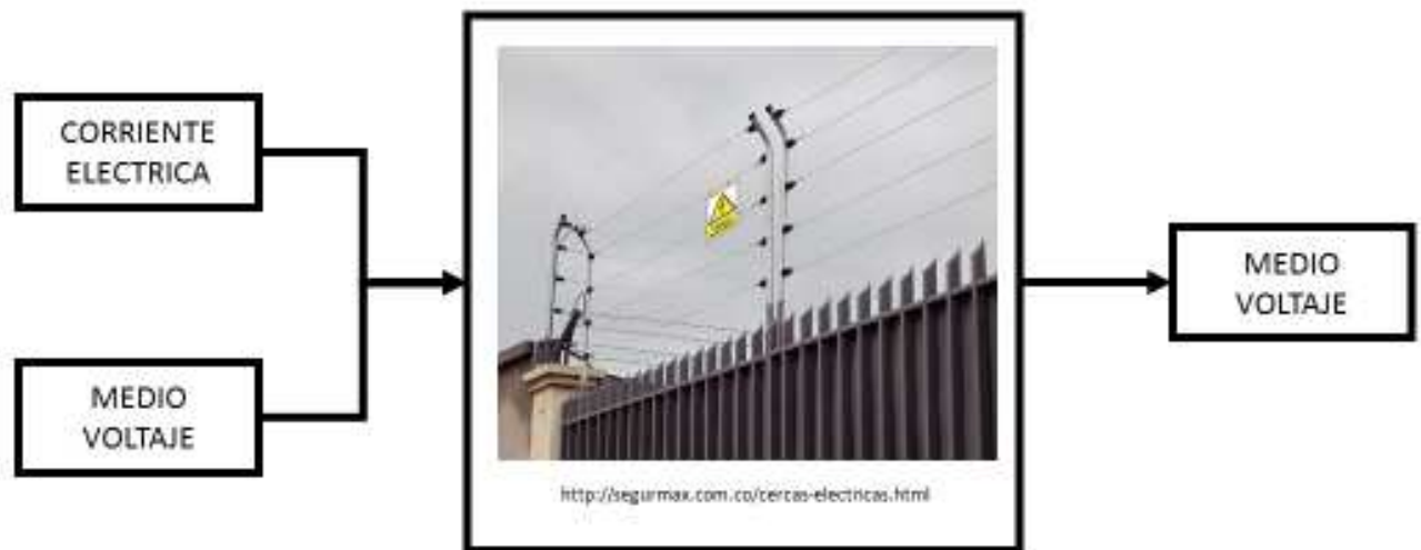
Figura 25 Sistema Cerca Eléctrica
