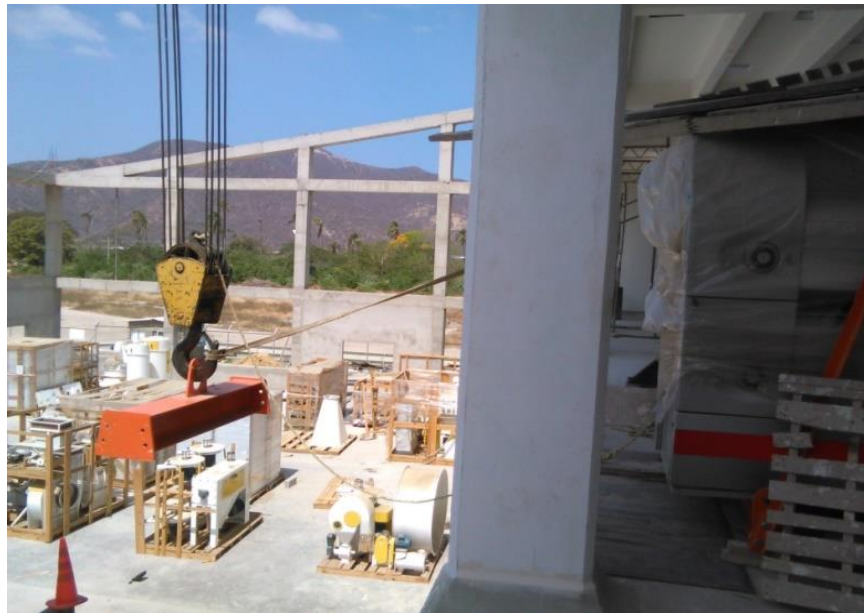
Figura 31. Viga de soporte de los bancos de cilindros
