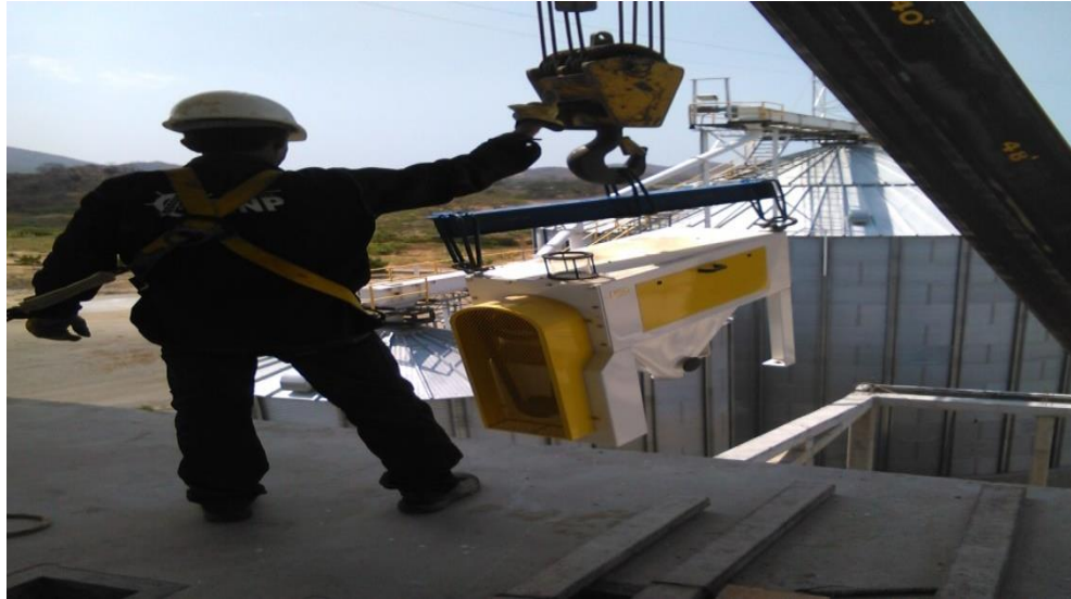
Figura 51. Izamiento de la Pulidora Horizontal
