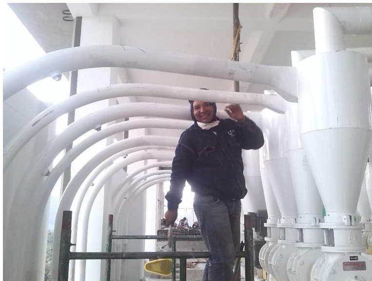
Figura 61. Montaje sistema neumático
