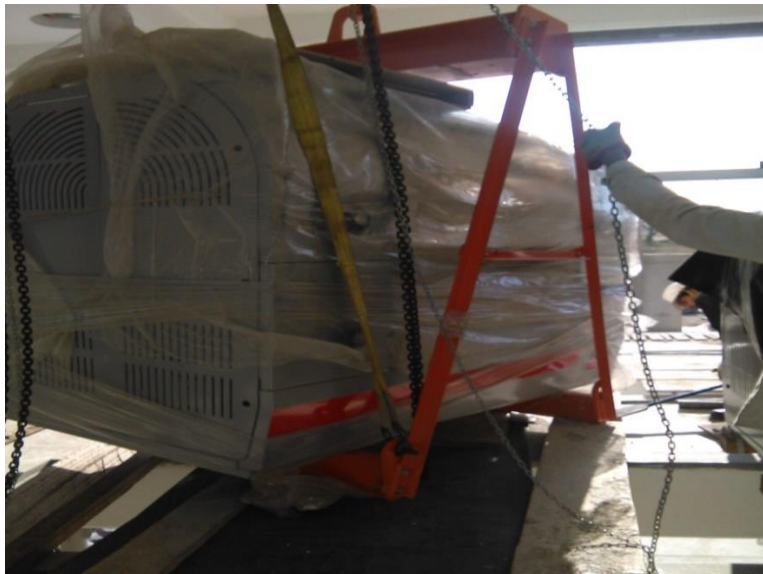
Figura 29. Izamiento del banco de cilindros usando eslingas sujetadas con grilletes
