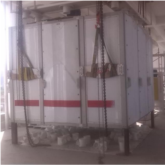
Figura 62. Instalación Cernedor
