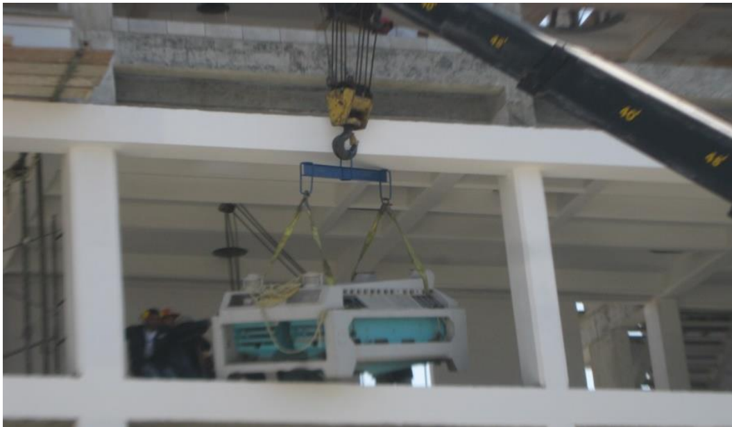
Figura 42. Izamiento del Sasor
