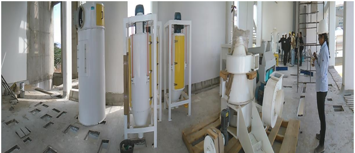
Figura 54. Posicionamiento final de los equipos en el tercer piso
