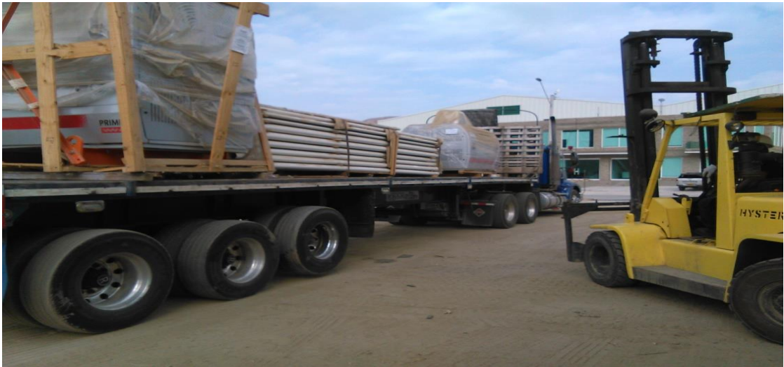
Figura 49. Transporte de la tubería del sistema neumático y de los bancos de cilindros
