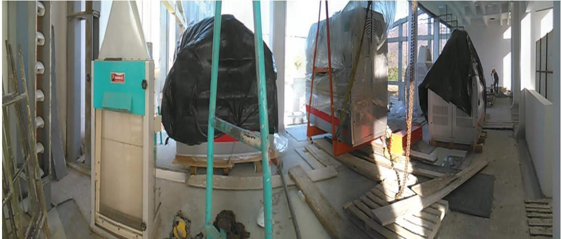
Figura 53. Posicionamiento final de los equipos en el segundo piso
