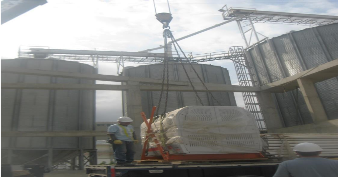
Figura 50. Izamiento de un banco de cilindros pequeño
