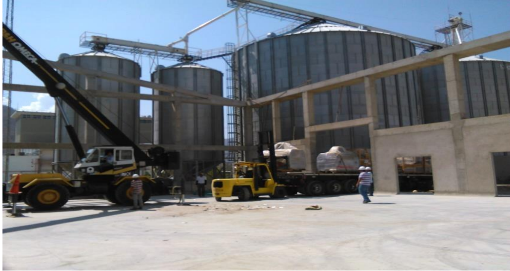
Figura 41. Recepción de los equipos en las instalaciones de Molinos San Miguel
