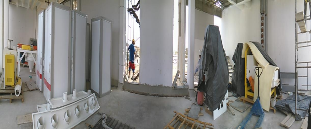
Figura 55. Posicionamiento final de los equipos en el cuarto piso
