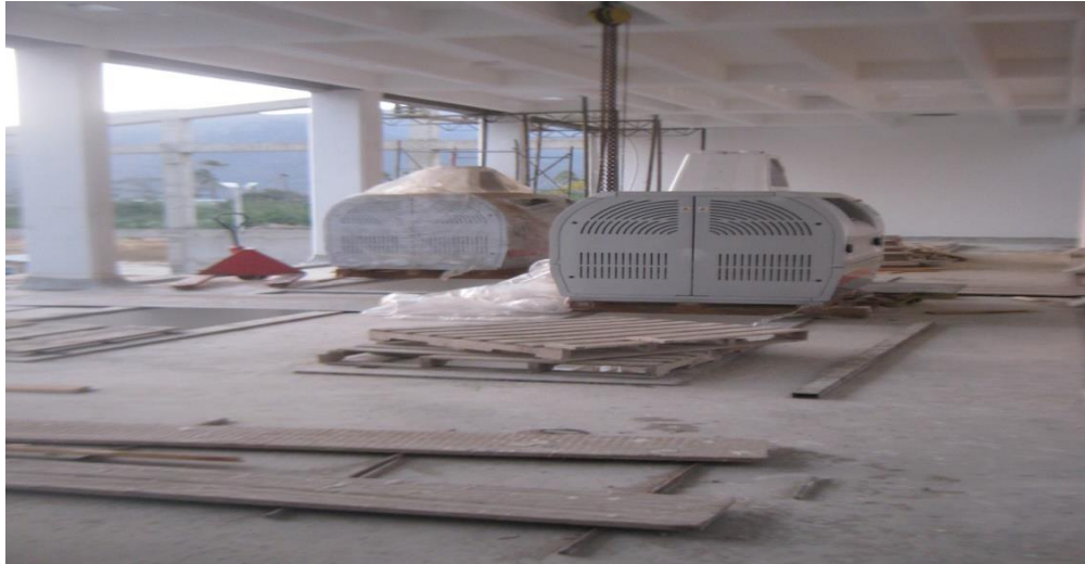
Figura 47. Posicionamiento de bancos de cilindros pequeños
