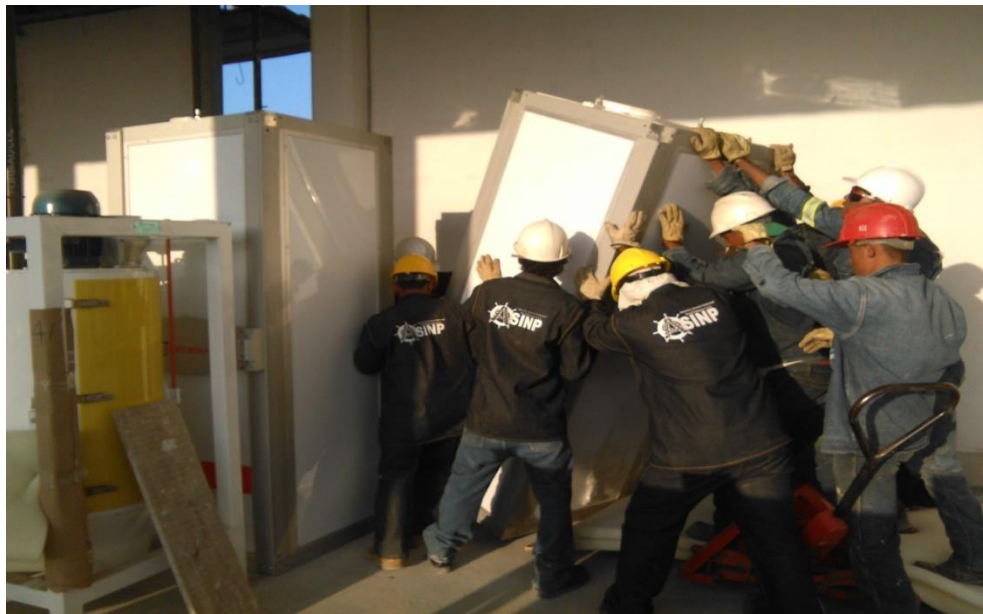
Figura 48. Posicionamiento de los módulos del Plansichter
