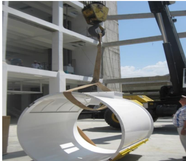
Figura 28. Izamiento del cuerpo del filtro JET usando eslingas en banda
