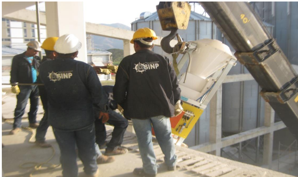
Figura 46. Izamiento de la balanza POND
