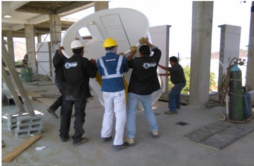
Figura 44. Posicionamiento del cuerpo cilíndrico del Filtro JET
