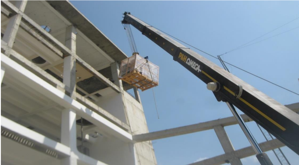
Figura 43. Izamiento del guagal que contiene el Microfiltro FPG-5
