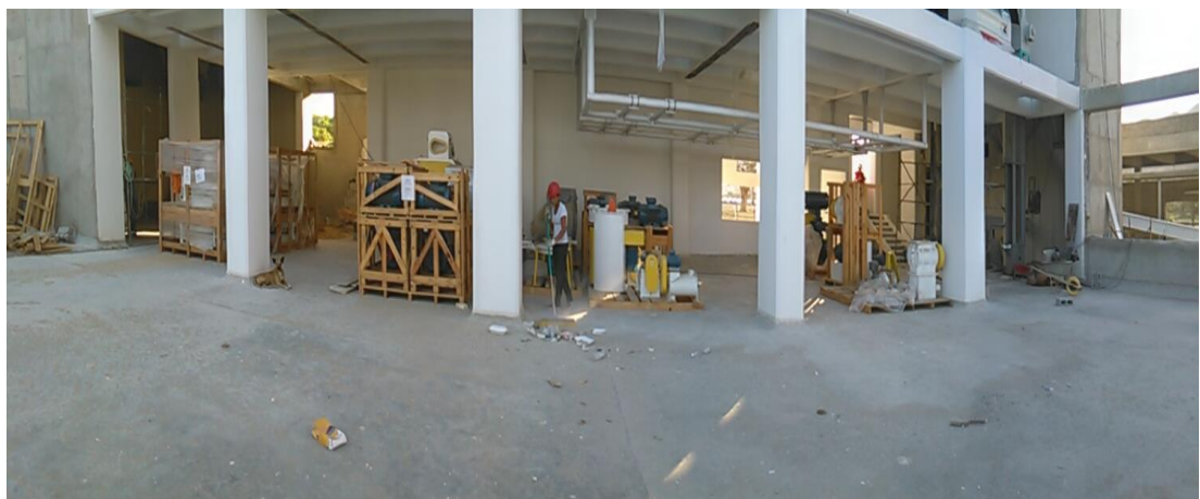
Figura 52. Posicionamiento final de los equipos en el primer piso
