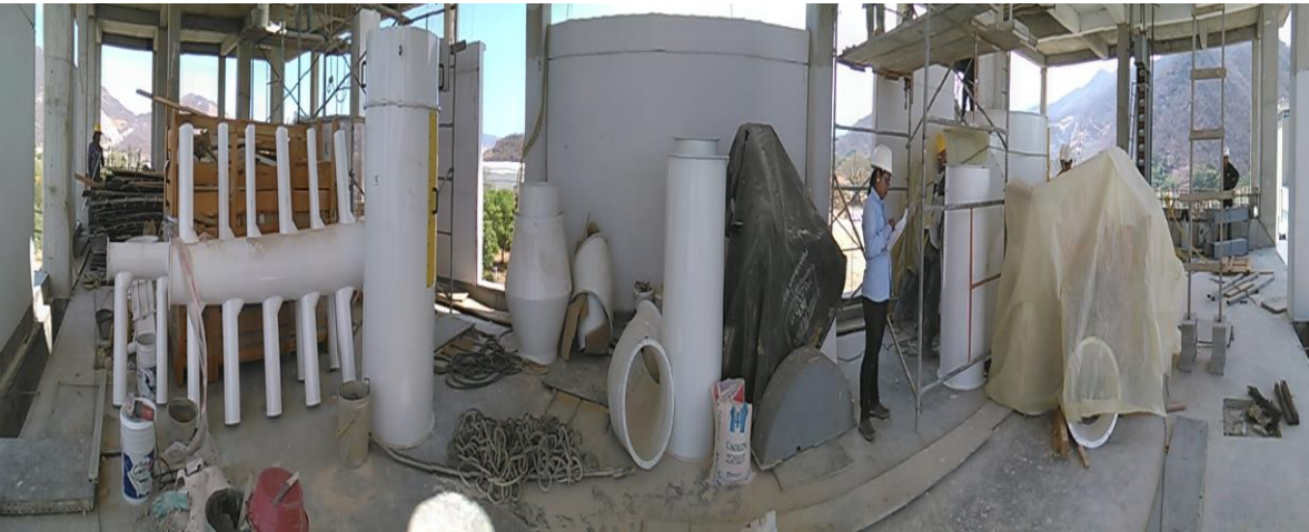
Figura 56. Posicionamiento final de los equipos en el quinto piso.
