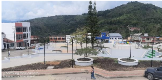
Figura 2. Parque principal de Pauna culminado el proyecto de adecuación y puesta en funcionamiento.
