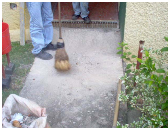
Figura No.26. Preparación del Tramo de Andén
