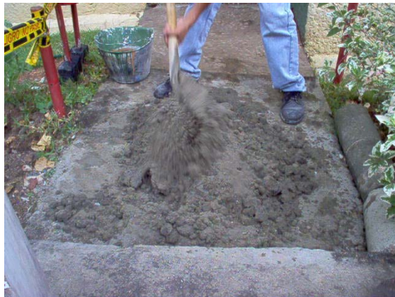
Figura No. 28. Preparación del Tramo de Andén
