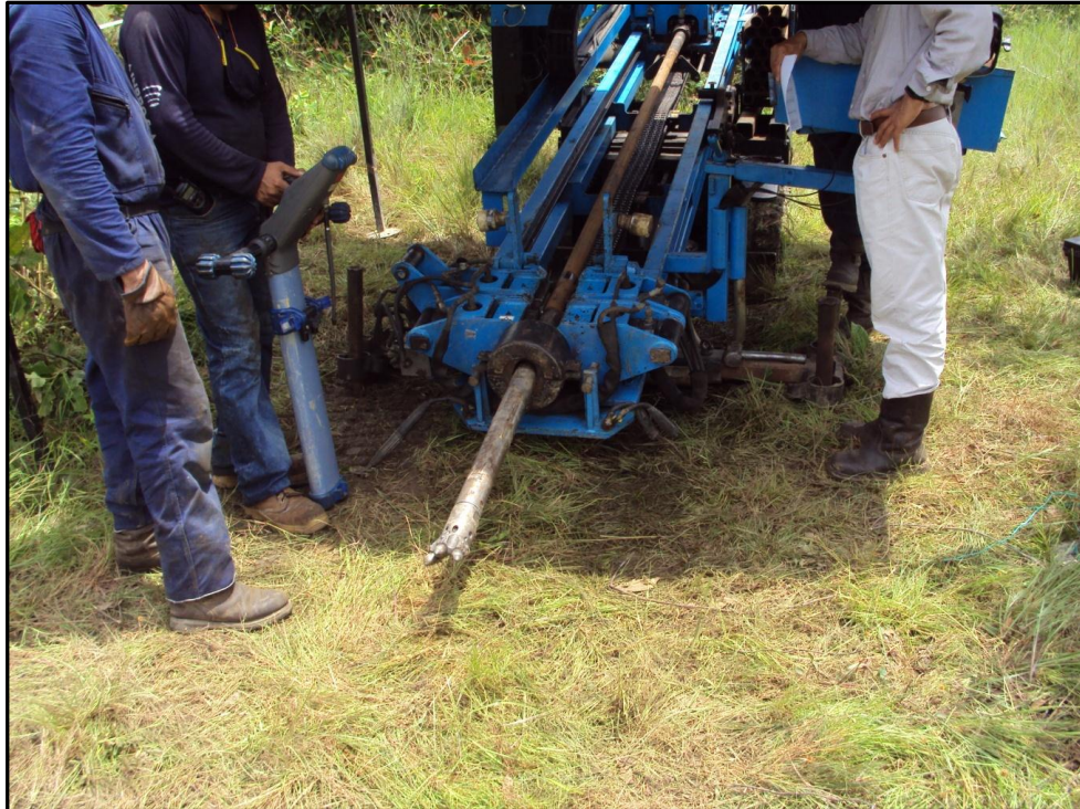
Figura 14. Equipo de PHD listo para iniciar la perforación piloto
