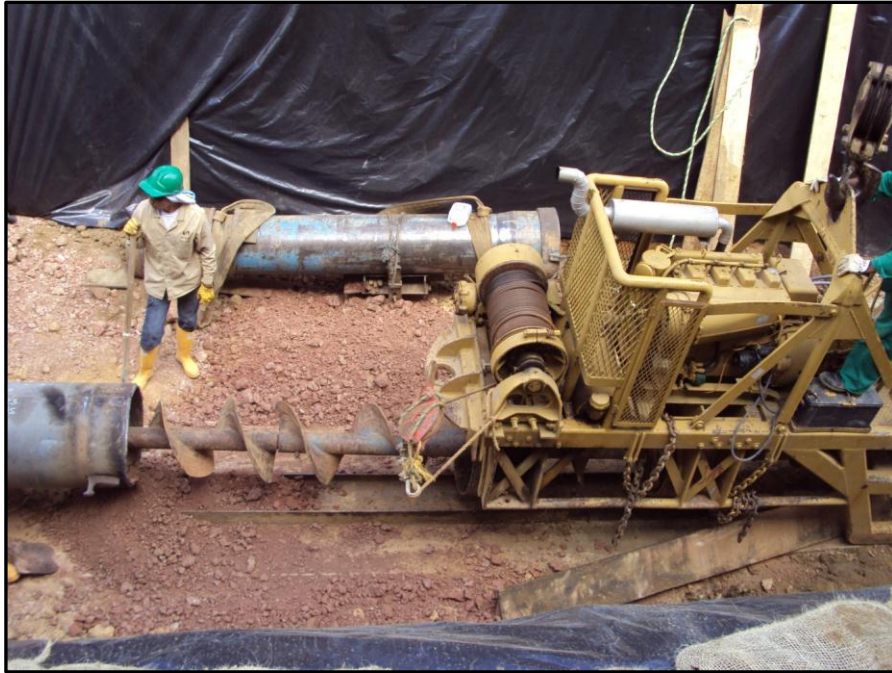
Figura 7. Limpieza mecánica del interior de la tubería
