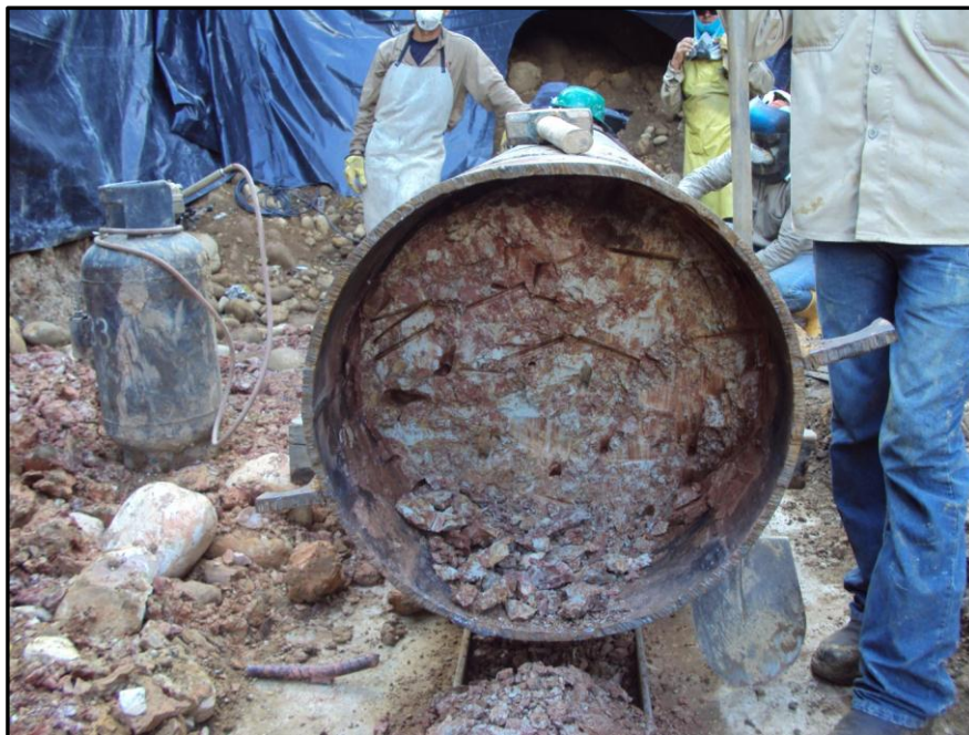
Figura 6. Tubería hincada con el suelo residual en su interior
