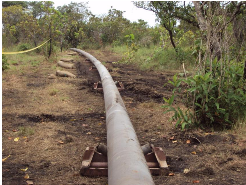
Figura 17. Lingada de tubería que será halada
