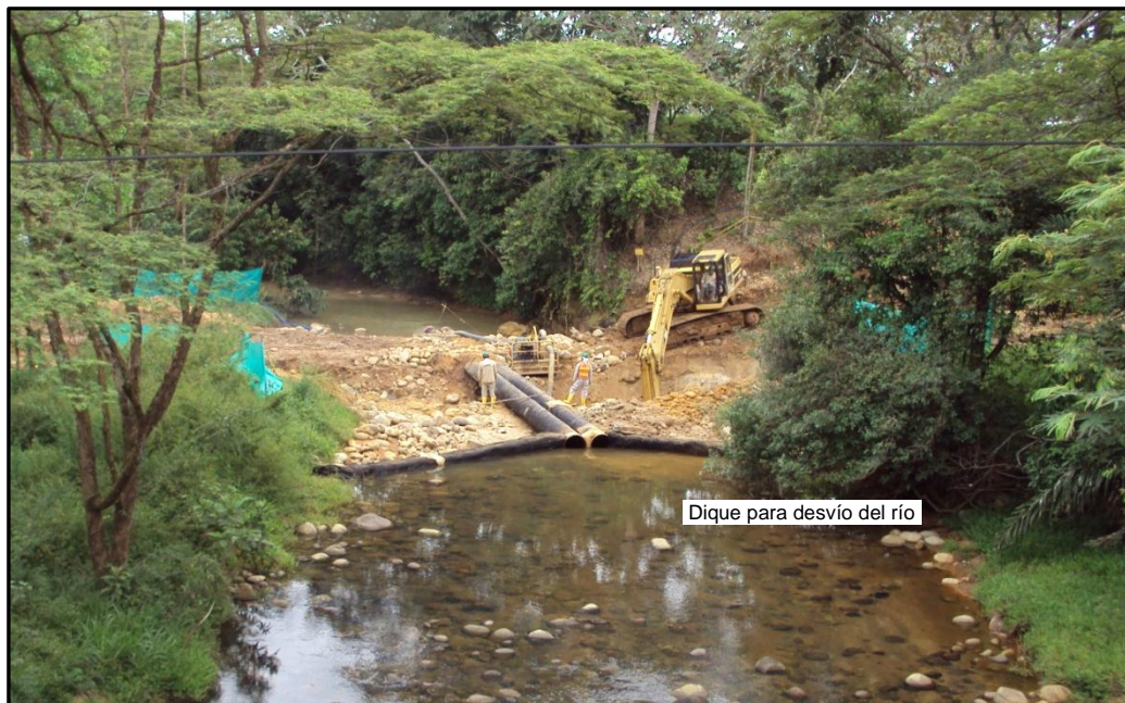
Figura 11. Instalación de tubería con zanja a cielo abierto
