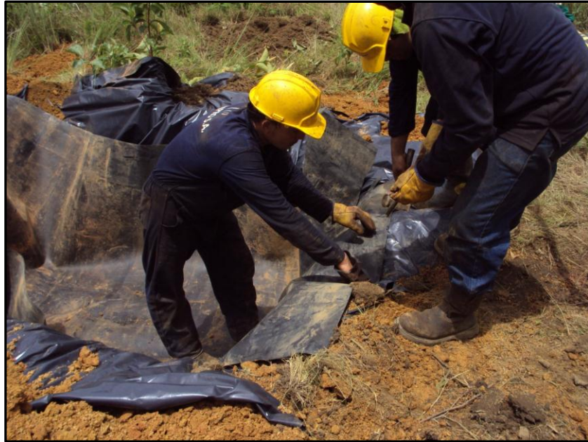
Figura 13. Preparación de la piscina de lodos
