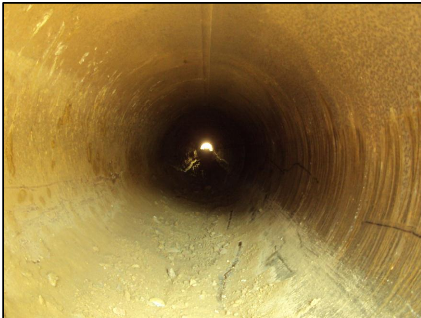
Figura 8. Interior de la tubería luego de haber sido limpiada
