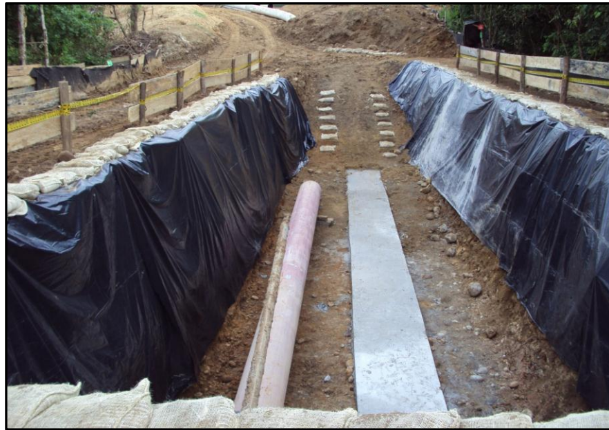
Figura 4. Caja de lanzamiento lista para iniciar trabajos
