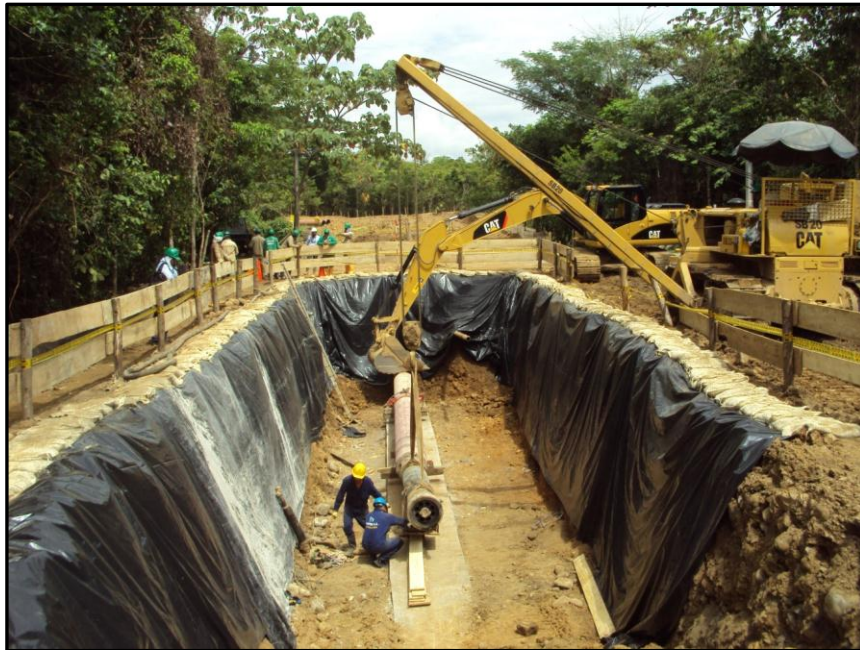
Figura 5. Montaje del martillo neumático y alistamiento para el hincado
