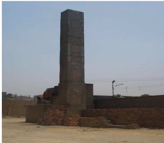
Figura 3. Horno para la industria ladrillera
