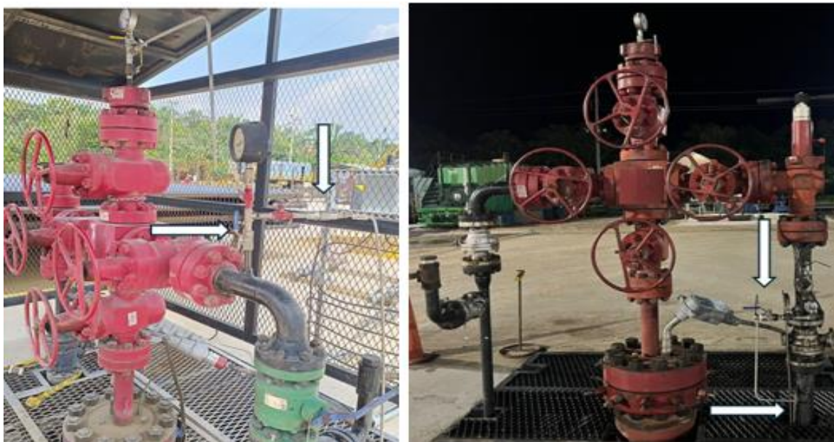
Ilustración 13. Montaje en cabeza de pozo de P27 y P32
