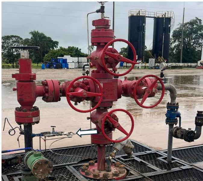
Ilustración 12. Montaje de punto de inyección vía anular en el pozo S05
