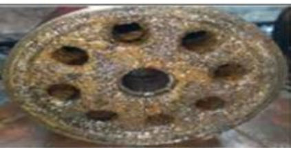
Fig 7. Los orificios de paso del fluido del cojinete se han reducido debido a la deposición de sedimentos.
