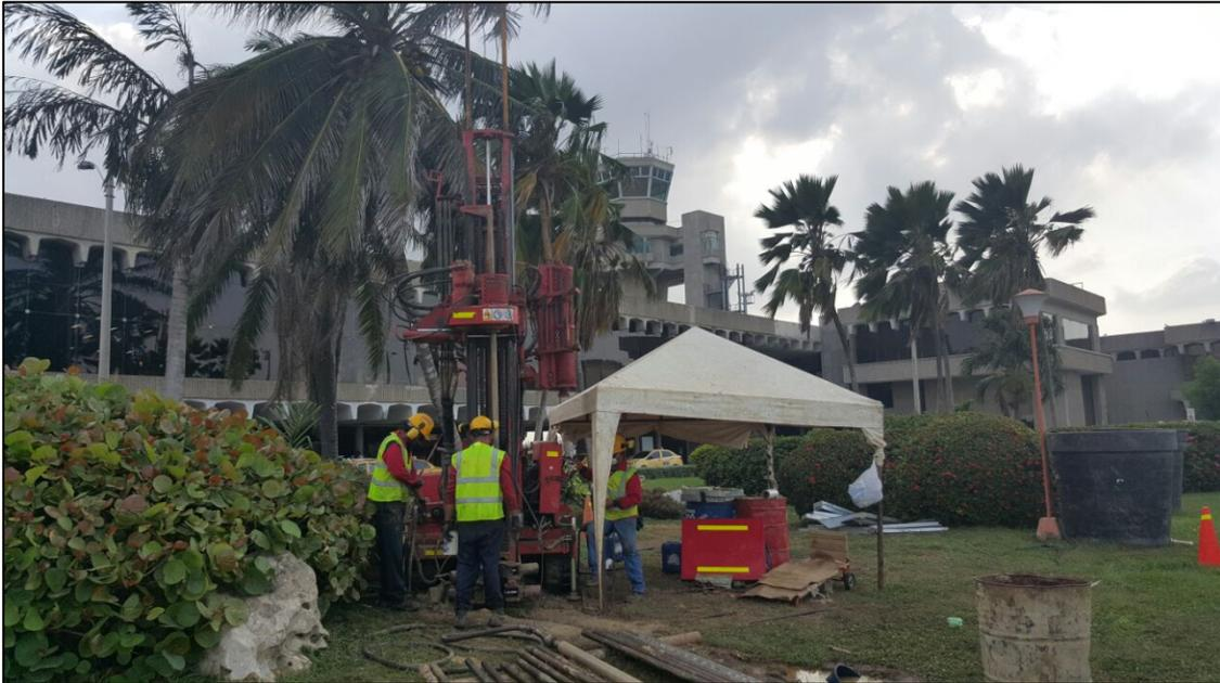
**Figura No 15 Ejecución de perforación con equipos de rotación (TP50-D) para la recuperación de muestras de suelos. Fuente: GEOTECO S.A.S.**
