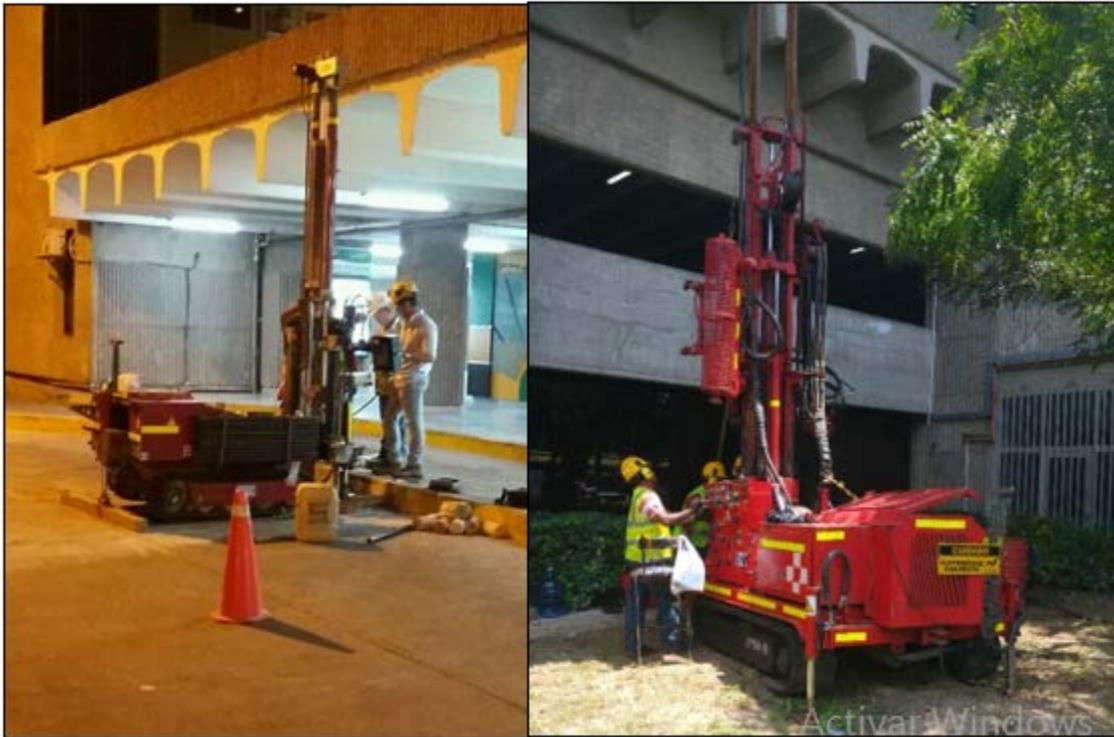
Figura No. 22 Equipo de perforación TP50-D (Martillo automático de caída libre) y equipo de perforación Pagani TG 63-150KN. Fuente: GEOTECO S.A.S.
