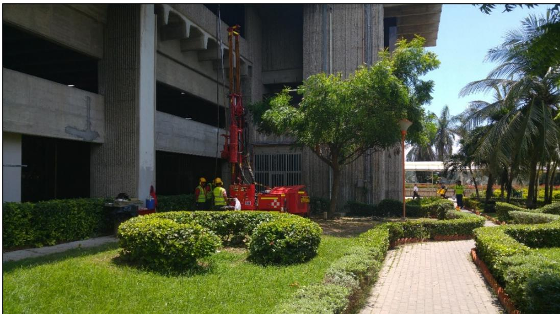
**Figura No 16 Ejecución de perforación con equipos de rotación (TP50-D) para la recuperación de muestras de suelos. Fuente: GEOTECO S.A.S.**
