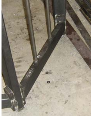
Figura 23. Soldadura de Ensamble Estación 5
