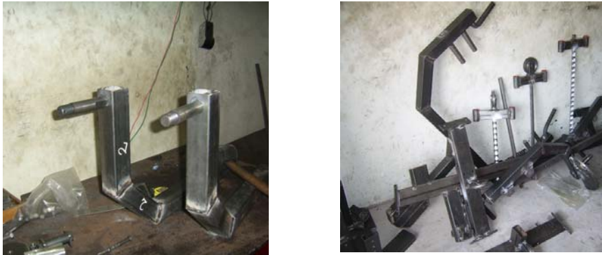
Figura 17. Soldadura Piezas Primarias
