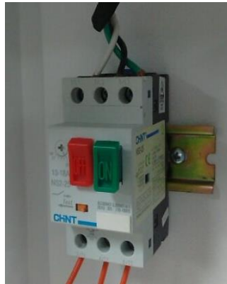
Figura 53. Conexiones guardamotor
