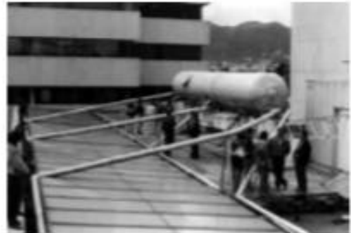
Figura 2. Calentador de la cafetería de la antigua Empresa de Energía de Bogotá (EEB). Construido en 1973 por el Centro Las Garzitas bajo un m 2 de colectores, tanque de 120 litros y desde entonces en operación. Detalles permitidos para la EEB por la Universidad Nacional de Colombia.
