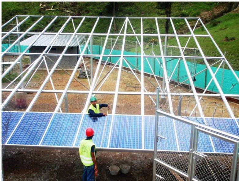
Figura 6. Instalación paneles solares.
