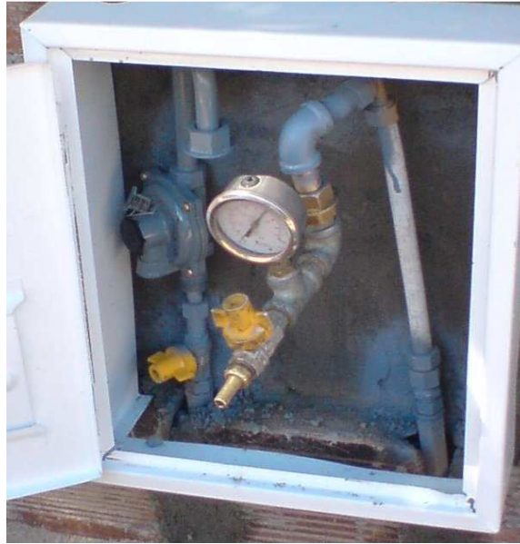
Figura 16. Ensayo de Hermeticidad (cabezal de prueba con manómetro)
