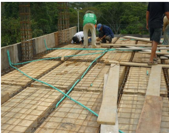
Figura 8. Fotografía ejemplo sistema de losa aligerada.
