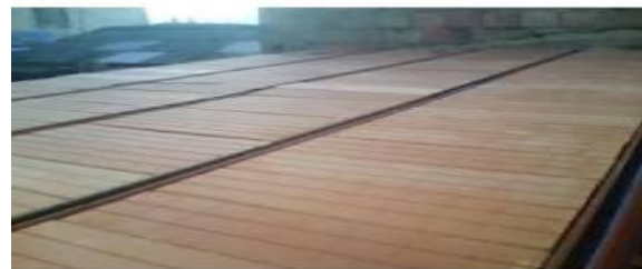
Figura 6. Fotografía ejemplo sistema de losa ladrillo estructural.
