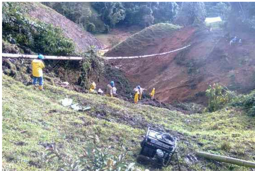
Figura 2. Ruptura del gasoducto mariquita - Cali debido a deslizamientos de tierra.
