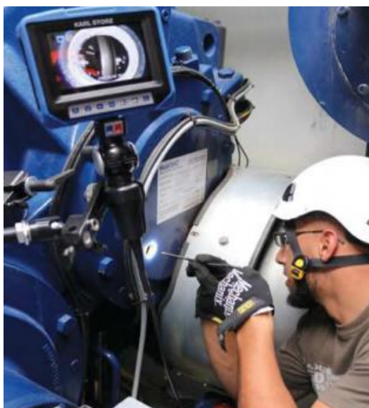
Figura 5. Inspección de un aerogenerador con un boroescopio
