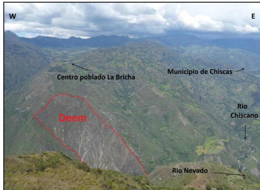
Figura 55. Escarpe de erosión mayor (Deem) con presencia de movimientos en masa como caídas y flujos de material, con desarrollo de surcos, cárcavas y erosión de tipo laminar de intensidades severas. Vereda La Bricha. Municipio de Macaravita.
