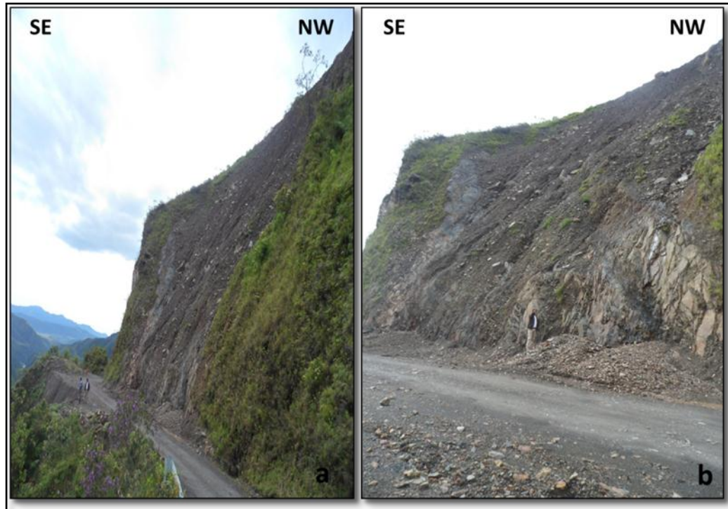
Figura 35. Deslizamiento traslacional planar localizado sobre la Formación Lutitas de Macanal, a) Recorrido del material (detritos y rocas) involucrado en el movimiento. b) Imagen donde se aprecia que este material afecta un carril de la vía y podría generar, a futuro, la obstrucción de la misma. Vereda Guivarin, municipio de Sácama.
