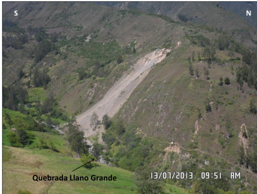
Figura 22. Deslizamiento traslacional planar, cuyo material constituyente (detritos, en su mayoría), puede llegar, a represar el cauce de la quebrada Llano Grande. Sitio Llano Grande, municipio de El Cocuy.
