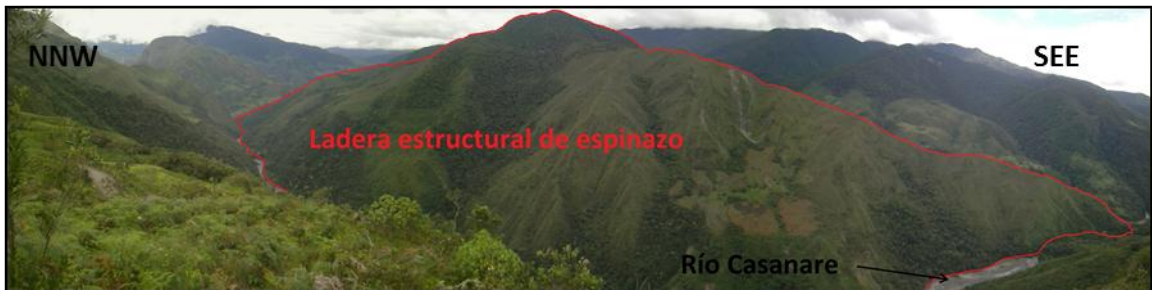
Figura 77. Ladera estructural de espinazo ubicada a orillas del río Casanare, donde se puede apreciar algunos procesos de movimientos en masa (deslizamientos traslacionales de tipo planar, caídas y flujos de material detrítico). Vereda Los Curos, municipio de La Salina.
