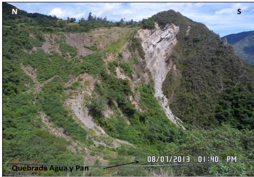
Figura 14. Movimiento en masa correspondiente a un deslizamiento traslacional planar y a una caída de rocas a orillas de la quebrada Agua y Pan; cauce que podría ser represado, debido al material desplazado por este movimiento. Vereda El centro, municipio de San Mateo.
