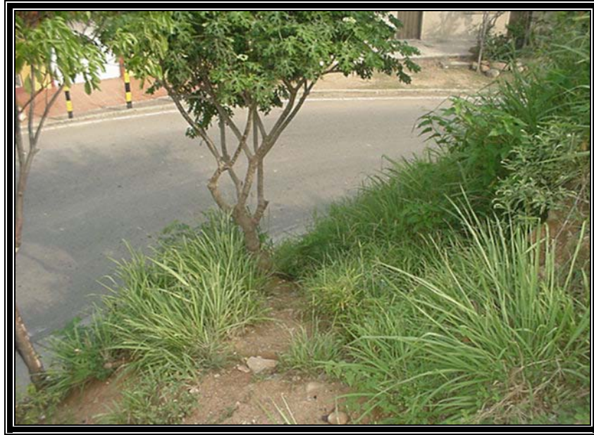
Foto 20. Lugar en donde las canaletas perimetrales de esta etapa entregaría sus aguas pluviales, a una caja que se diseñaría sobre la vía.
