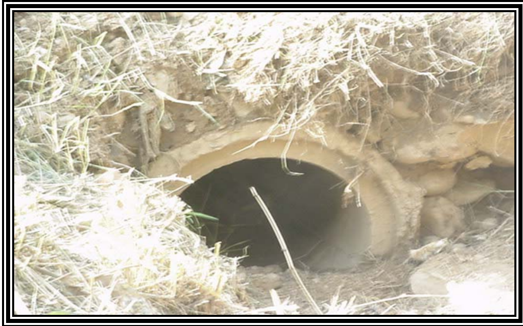
Foto 14. Tubería a remodelar en donde se conectará el desarenador
