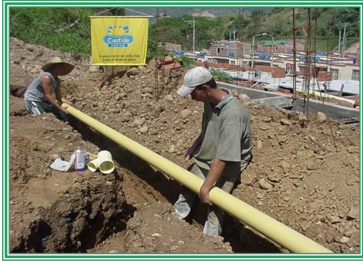
Foto 5. Instalación de Tubería Sanitaria
