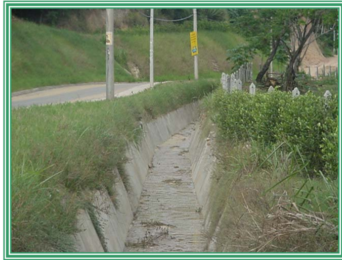
Foto 7. Canal en concreto y estabilización de taludes
