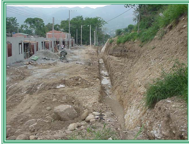
Foto 3. Excavación en roca de la zanja
