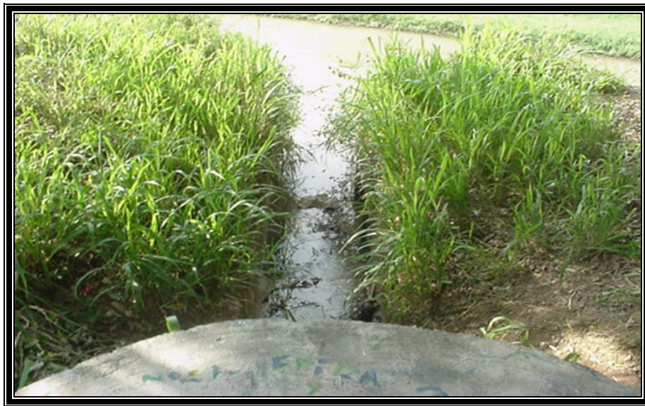
Foto15. Entrega de aguas lluvias al Río
