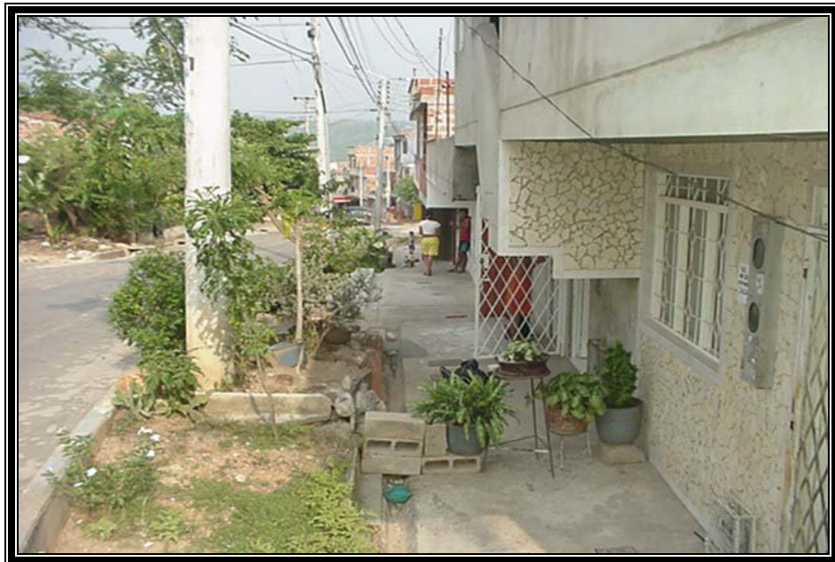
Foto 23. Parte frontal de Etapa III que entregará las aguas Lluvias directamente a la vía.
