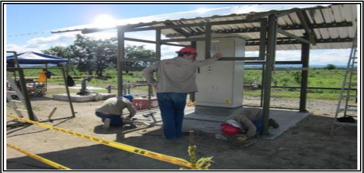
Figura 33. Construcción de caseta
