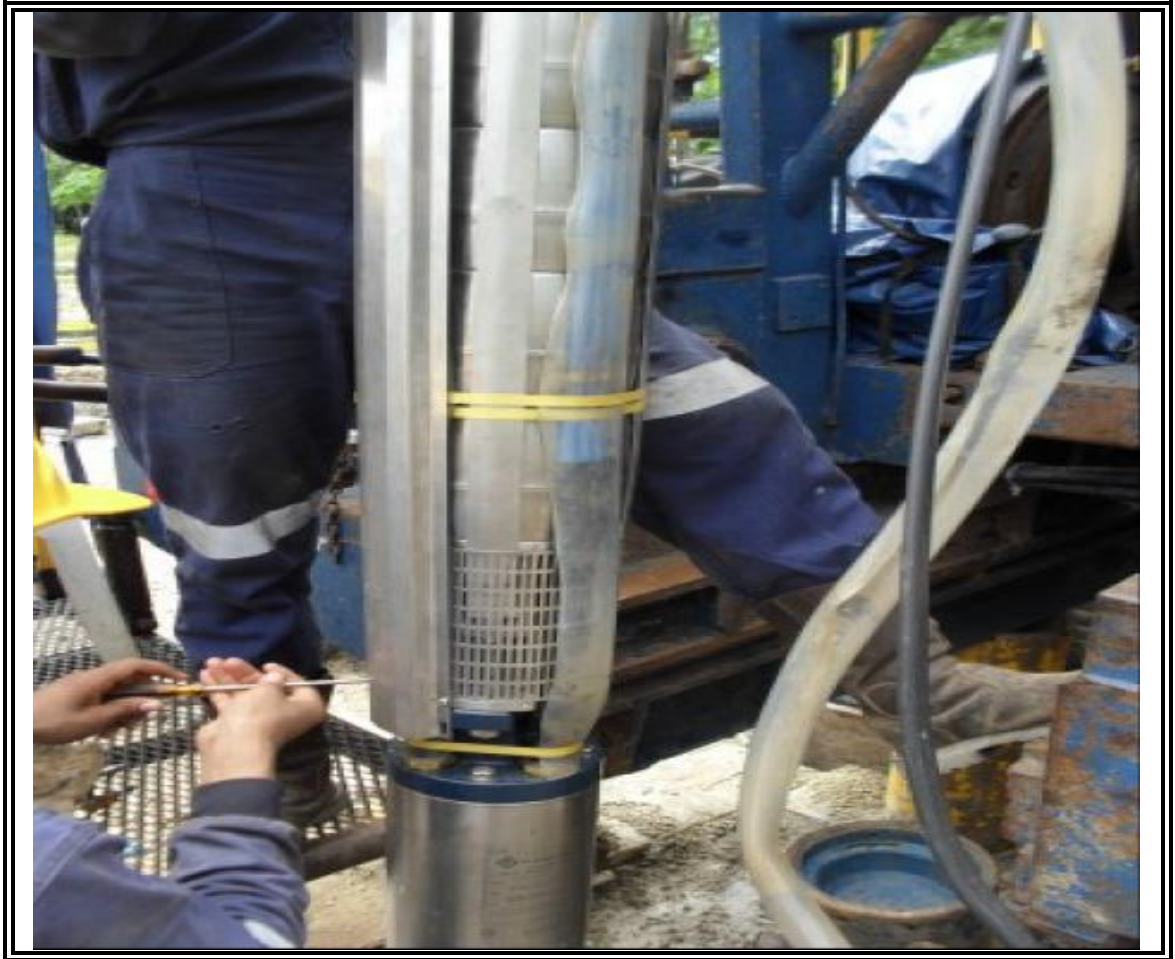
Figura 27. Instalación de bomba y motor
