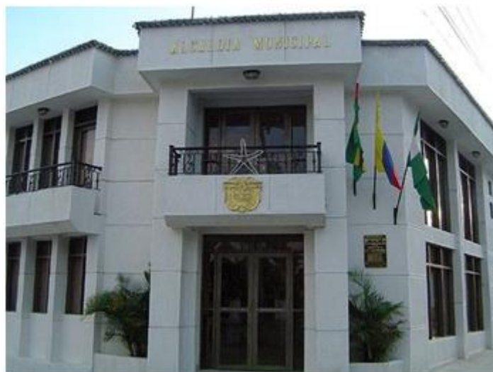
Ilustración 6. Instalaciones Alcaldía Municipal de Güepa
