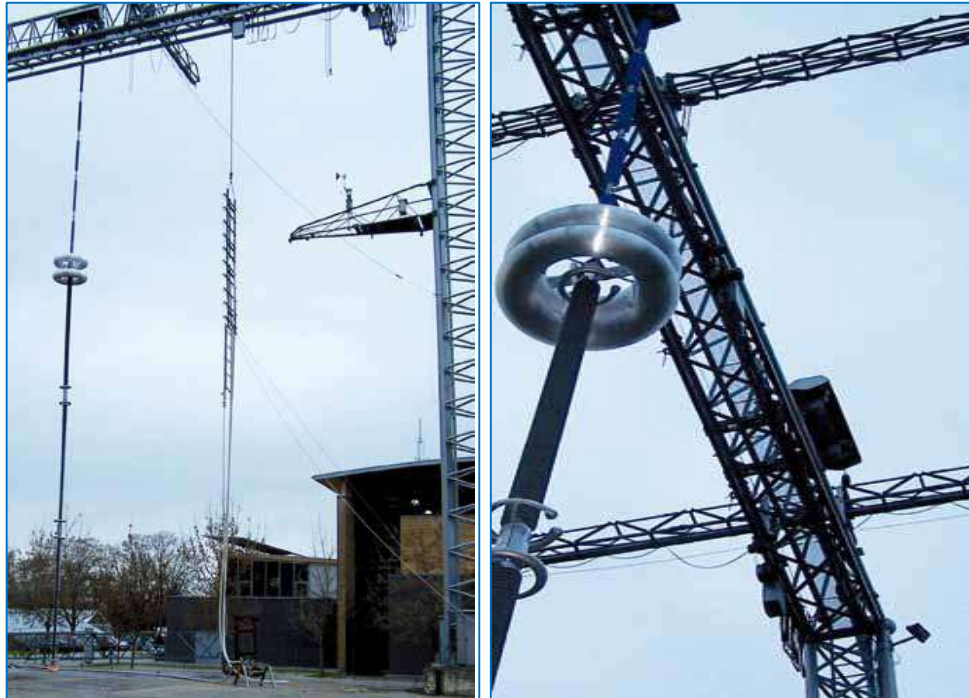
Figura 55. Transductor de corriente óptico (OCT); Ensayo dieléctrico en el laboratorio de alta tensión de Graz (Austria) [38].
