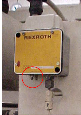
Figura 12. Presóstato de presión diferencial Unidad Motriz Hidráulica (Fotografía tomada en Bavaria S.A. Cervecería de Boyacá)
