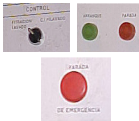
Figura 14. Selector, pulsadores salientes y pulsador de seta (Fotografía tomada en Bavaria S.A. Cervecería de Boyacá)
