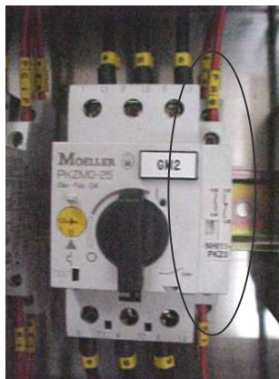
Figura 15. Guardamotor con contactos auxiliares laterales (Fotografía tomada en Bavaria S.A. Cervecería de Boyacá)
