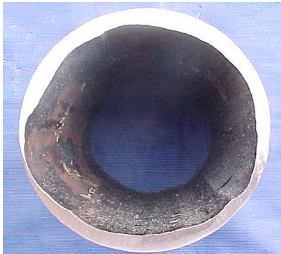
Figura 5. Tubería fuera de servicio por disminución severa del espesor de pared.
