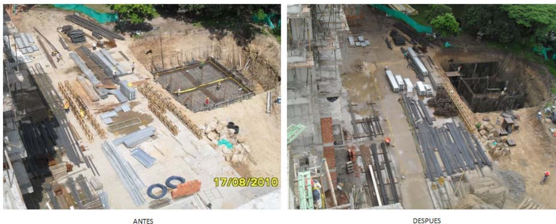
Figura 46 : Implementación 5S en patio de materiales
