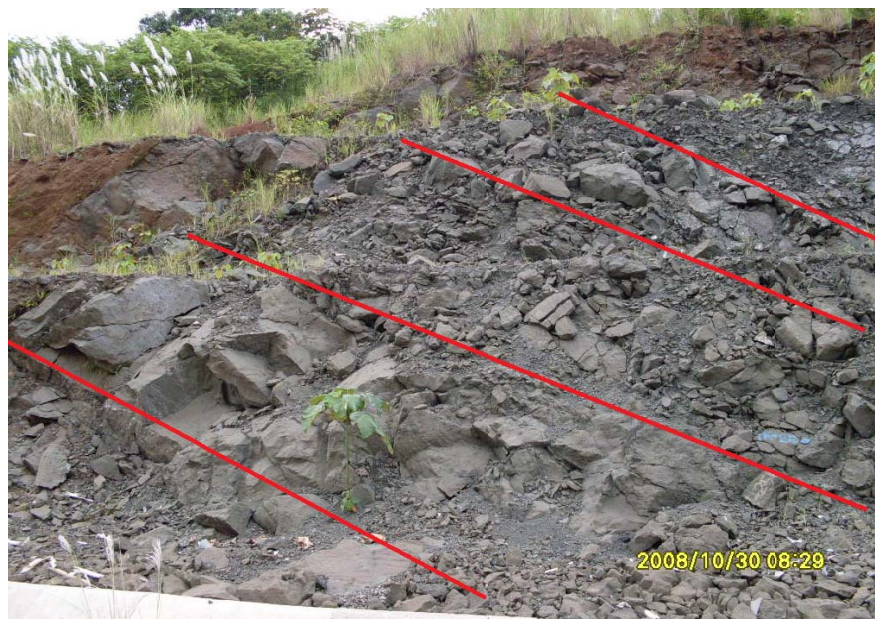
FIGURA 3.9: Capas guía de la formación Baso Obispo usadas en la elaboración de las secciones estructurales.
