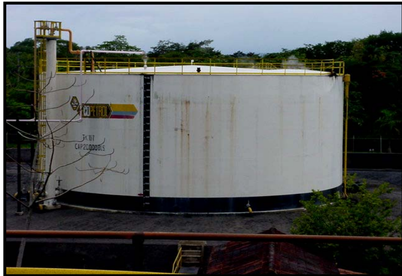
Figura 14. Tanques de almacenamiento de agua
