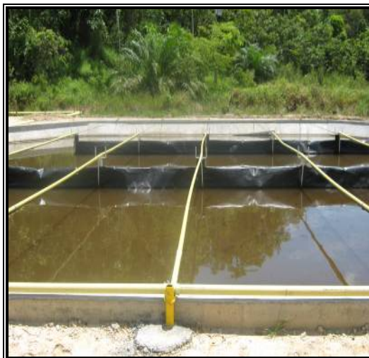
Figura 61. Estado final de la segunda piscina de tratamiento de la batería Payoa
