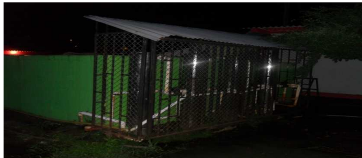
Fotografía 5. Planta potabilizadora de agua
