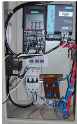
Figura 29. Elementos de arranque instalados.
