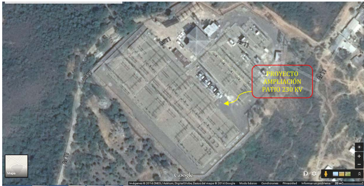
Figura 9. Vista satelital Subestación San Mateo
