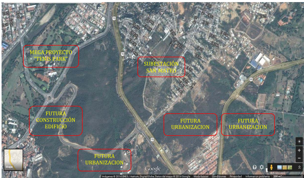
Figura 7. Vista satelital de la Subestación San Mateo, Barrio Bogotá
