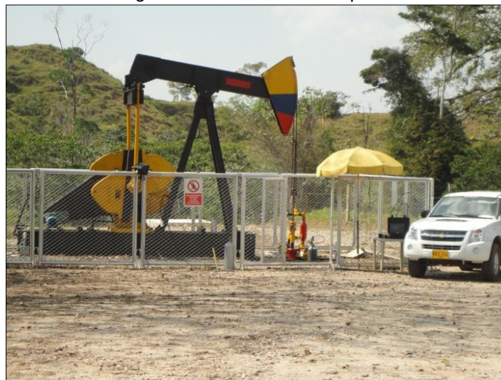
Figura 34. Cerramiento del pozo.
