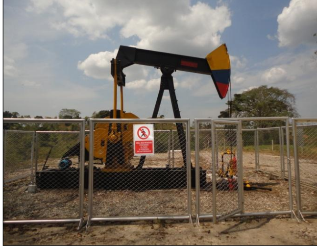
Figura 29. Estado del pozo.
