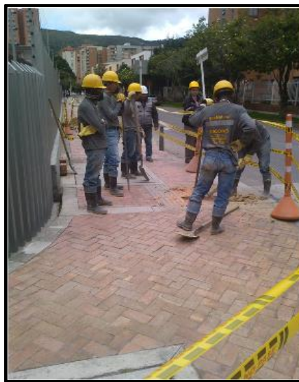
Figura 7. Instalación de tubería, levantamiento de suelo
