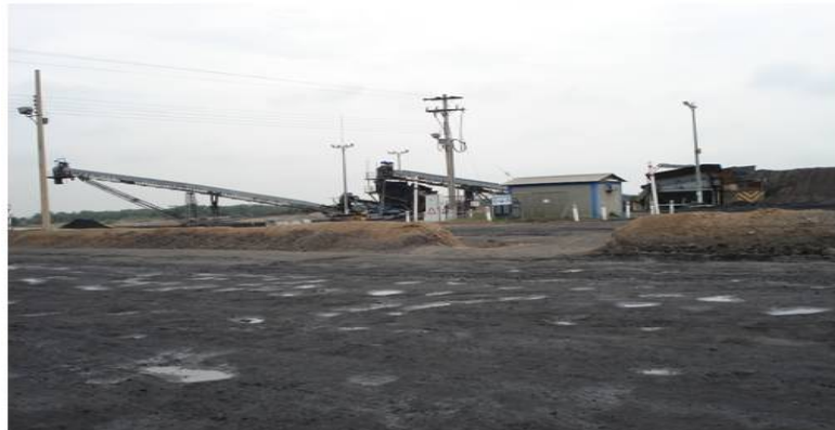
Figura 37. Trituradora de Carbón en acopio.
