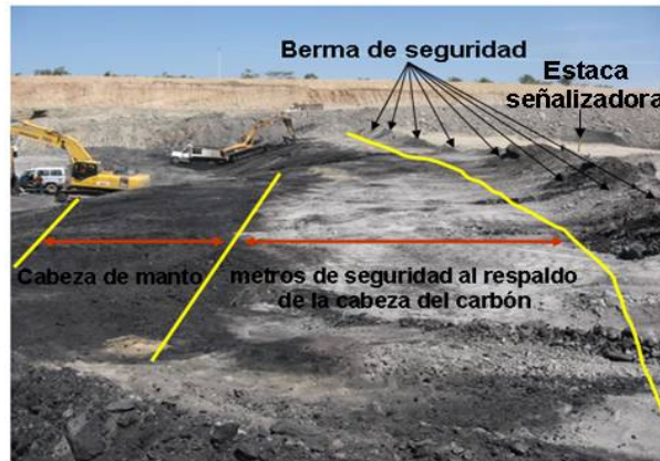
Figura 23. Berma de seguridad para proteger área de extracción. Modificado. C.I Prodeco S.A.
