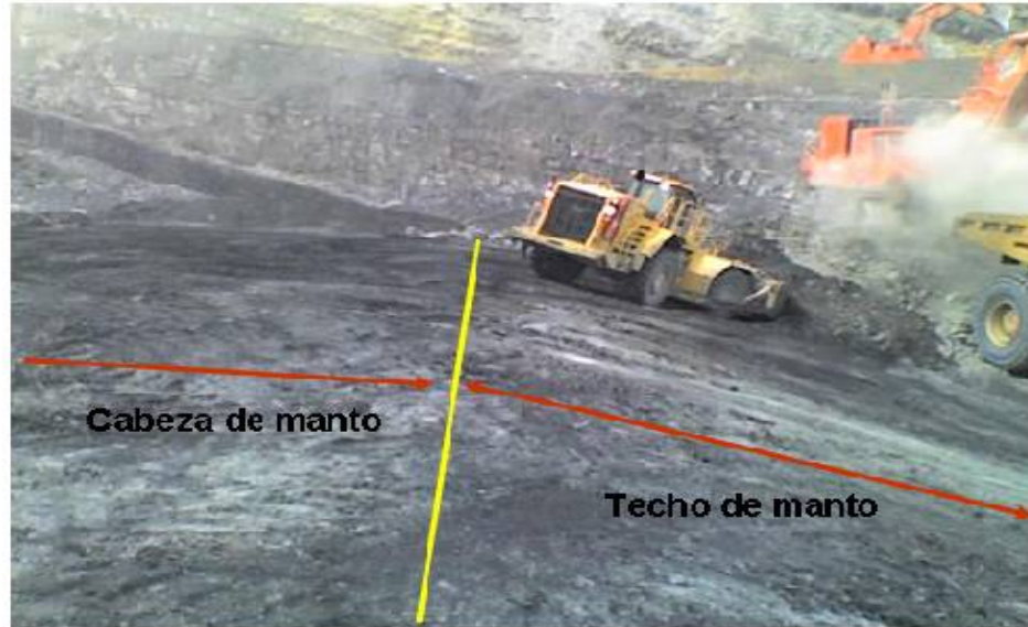
Figura 25. Descapote simultáneo con limpieza de techo de manto.
