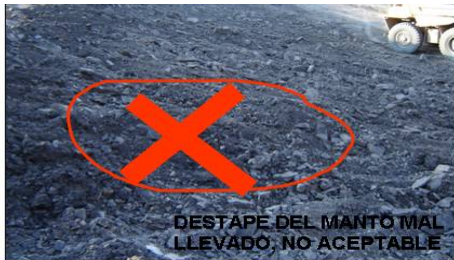
Figura 16. Techo afectado del manto de carbón
