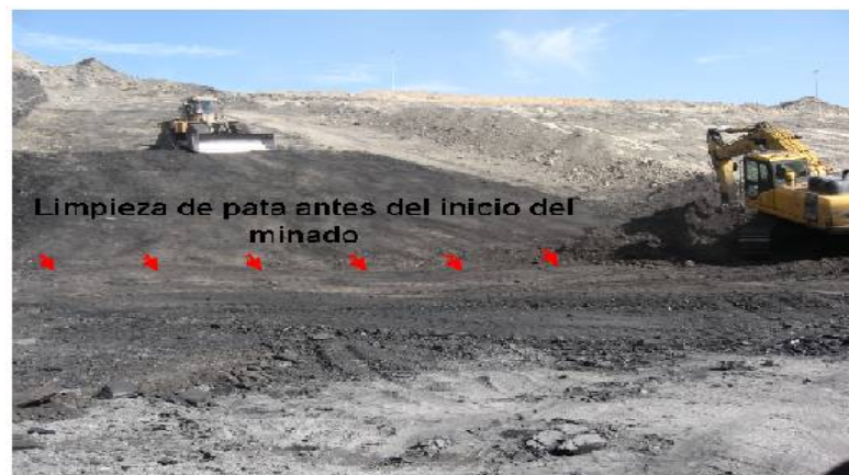
Figura 27. Definición y limpieza de la pata del manto con excavadora y tractor de llantas. Modificado. C.I Prodeco S.A.
