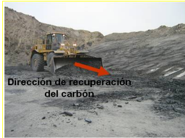
Figura 48. Recuperación de carbón sobre la traza.
