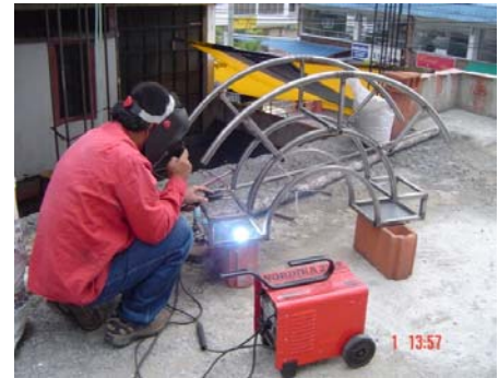
Figura N. 46. Hierro soldado para la estructura.
