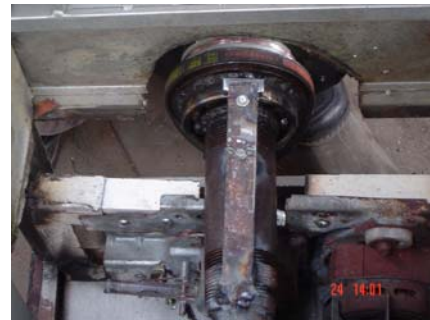
Figura N. 61. Poleas y bandas superiores. Freno de seguridad para el motor.
