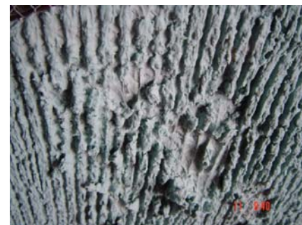
Figura N. 58. Para la adherencia de la resina se utilizó una malla zaranda. Y Resina color gris.
