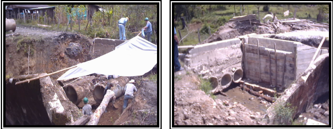
Figura 9. Fotografías construcción puente sobre la quebrada “Primavera” vereda Mombita
