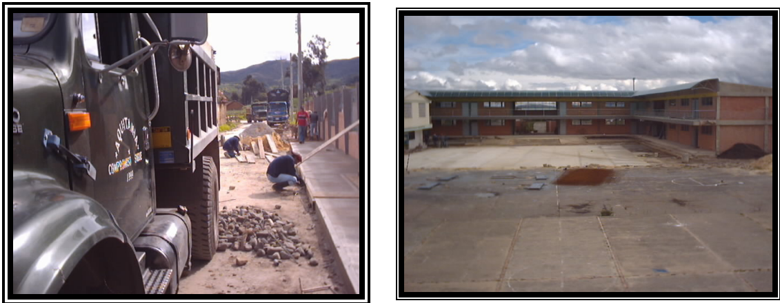
Figura 4. Fotografías construcción sede primaria colegio “Ramón Ignacio Avella”
