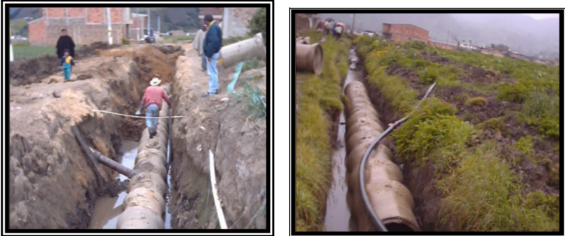
Figura 8. Fotografías construcción alcantarillado Carrera 12
