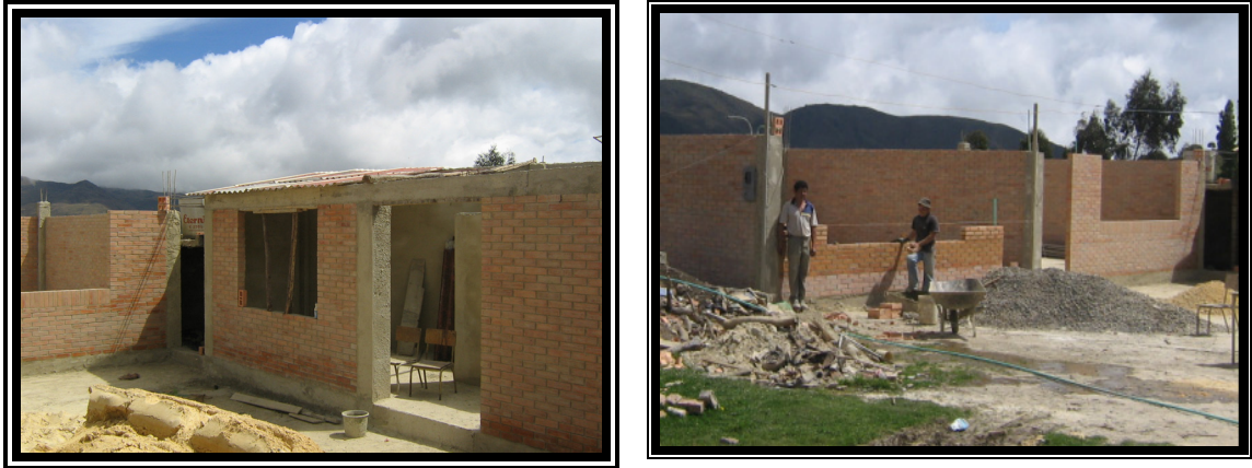
Figura 6. Fotografías adecuación y ampliación escuela “San José” vereda de Suse
