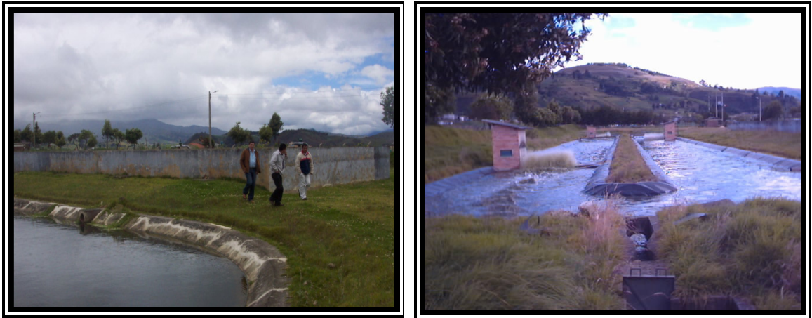
Figura 7. Fotografías optimización planta de tratamiento de Aguas Residuales
