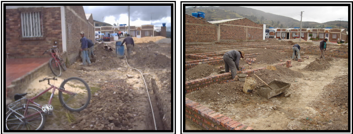
Figura 10. Fotografías terminación construcción urbanización “San Luís de Guaquira”
