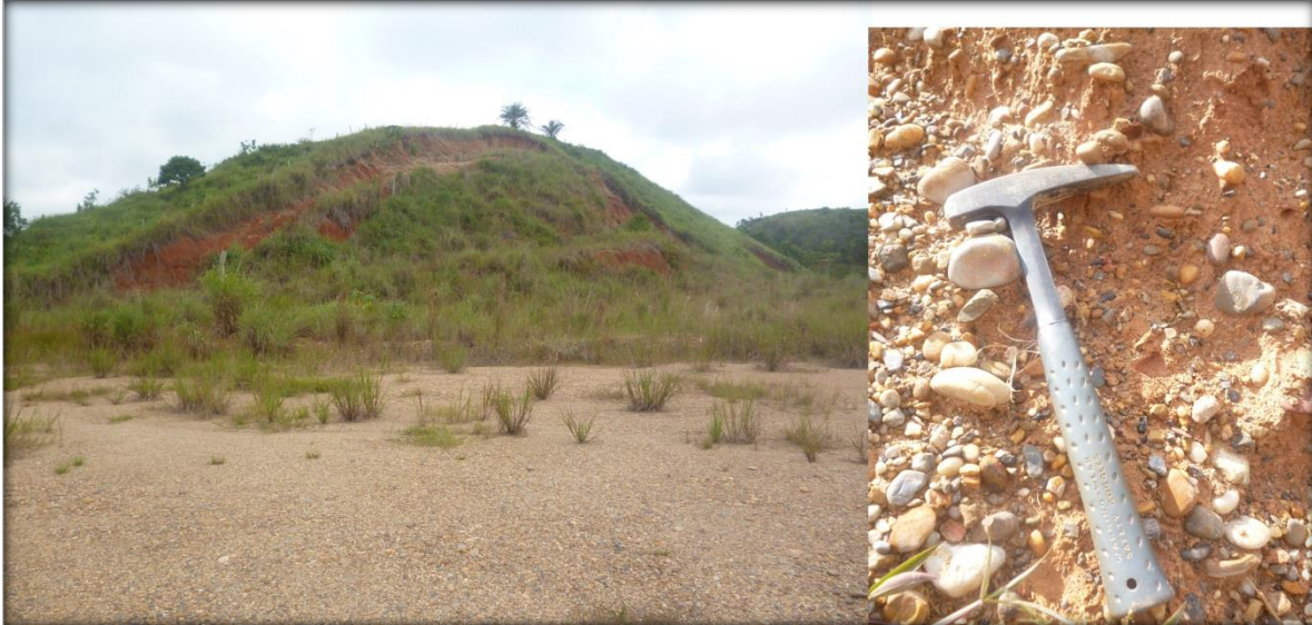
Figura- 28. Panorámica de deslizamiento traslacional 026814 y detalle del material en la pata del talud por donde pasa una corriente de agua, observado en el sector conocido como San Isidro en el municipio de Barrancabermeja.
