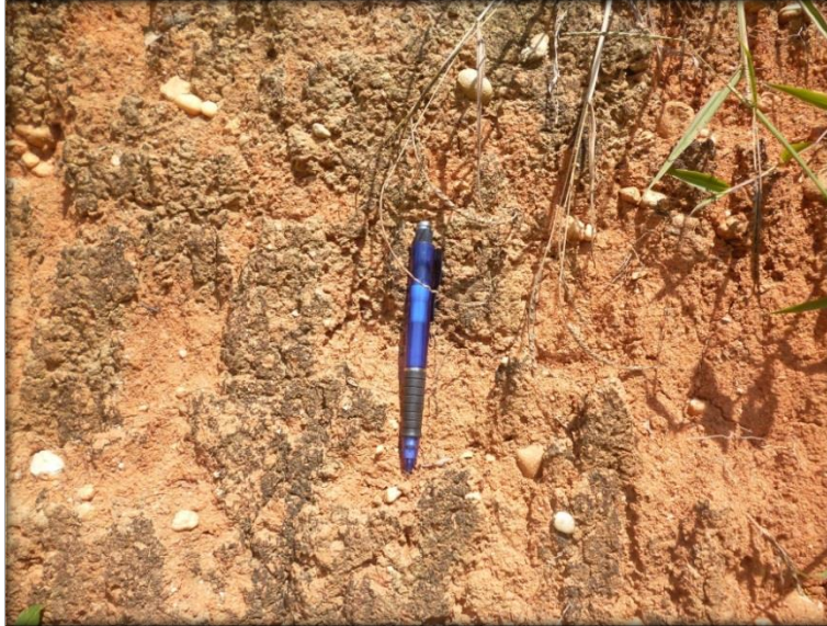
Figura- 23. Detalle del material que está reptando en el movimiento 026823 en observado entre el casco urbano del municipio de Barrancabermeja y el aeropuerto los Yarigues.
