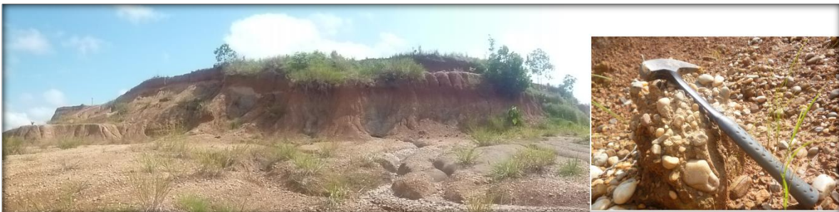
Figura- 29. Panorámica de depósito aluvial abigarrado tiene cárcavas profundas y zanjones con estoraques que representan el nivel que debería tener el suelo, resultado de la erosión hídrica y eólica. A unos metros del deslizamiento 026814 observado en el sector conocido como San Isidro en el Municipio de Barrancabermeja.
