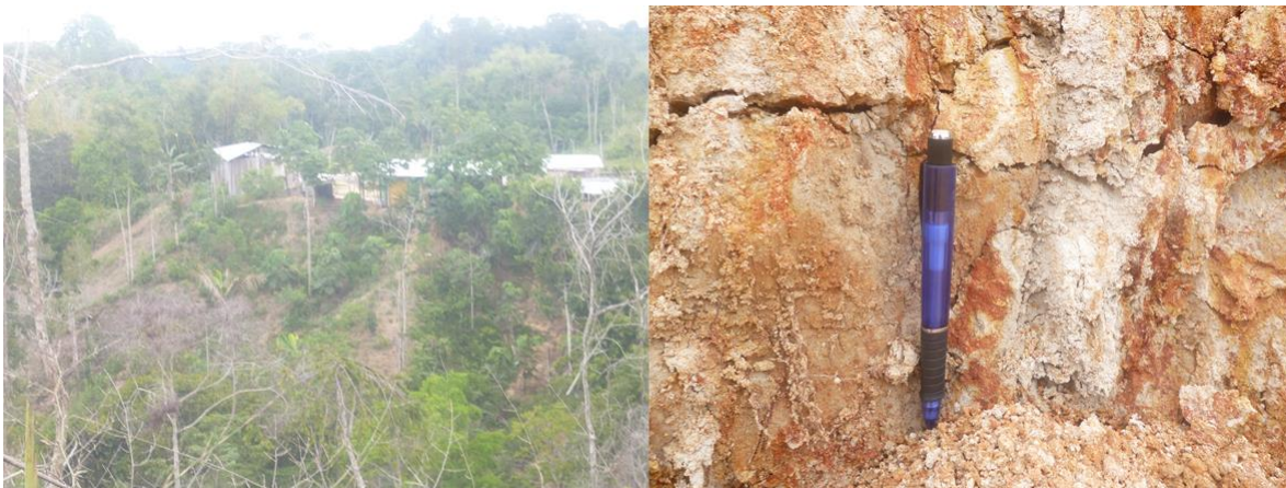
Figura- 42. Panorámica de Deslizamiento Traslacional y detalle del material en movimiento corresponde con el punto de inventario 26817 observado en la vereda Vizcaína.
