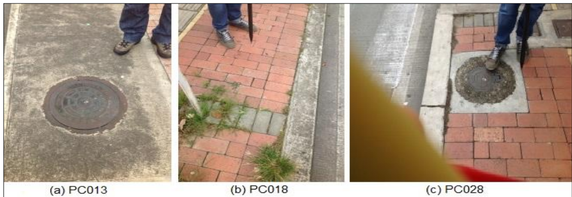
Figura 52. Levantamiento de las coordenadas de los Puntos de Control 13,18 y 28 en la Cra. 27 entre calles 14-18
