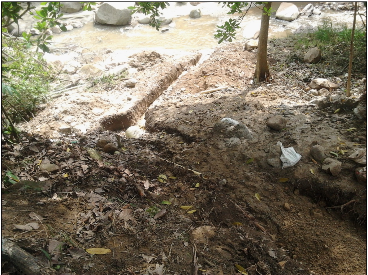
Figura 13. Punto de entrega de aguas lluvias a la Quebrada Aranzoque.
