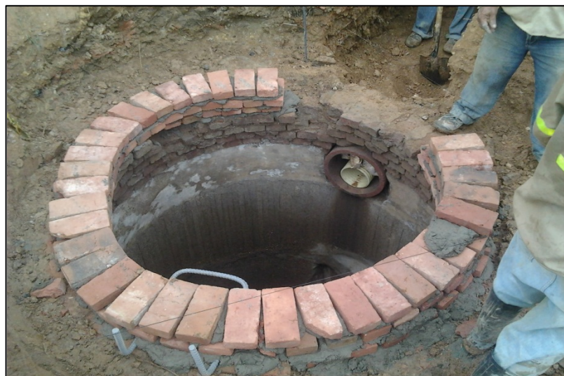
Figura 16. Pozo de inspección en construcción.
