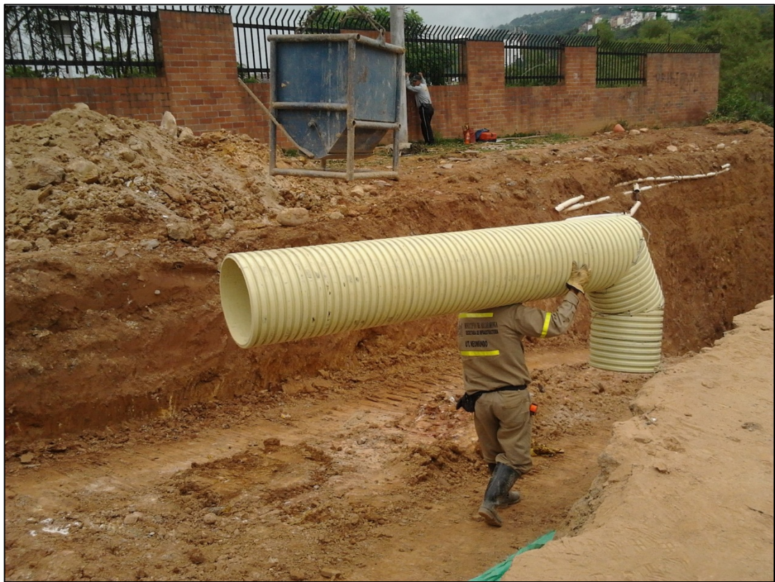
Figura 14. Cámara de caída
