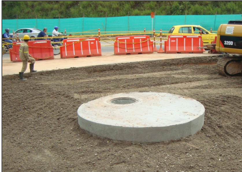
Figura 15. Pozo de inspección.
