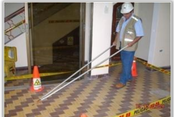
Figura 33 – Pinzas, conos y cinta de peligro.
