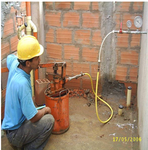
Figura 5 – Prueba de presión hidráulica
