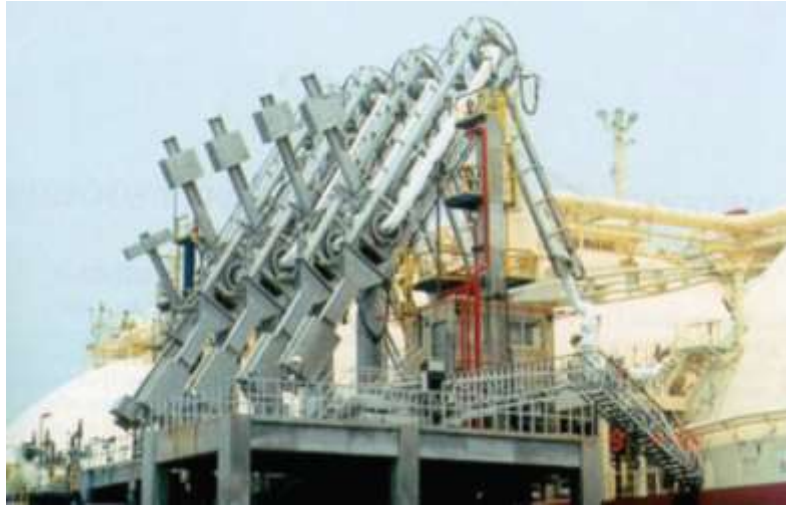
Figura 4. Brazos de descarga de GNL a tanques.
