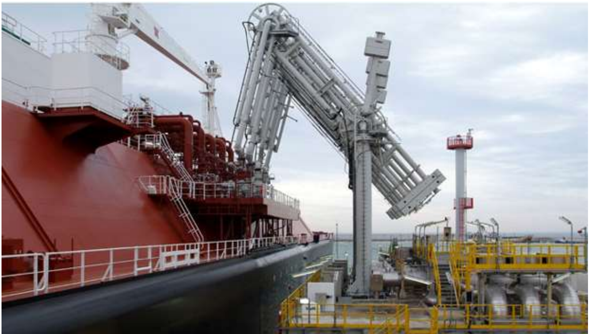
Figura 14. brazos de descarga y de retorno de Boil off gas
