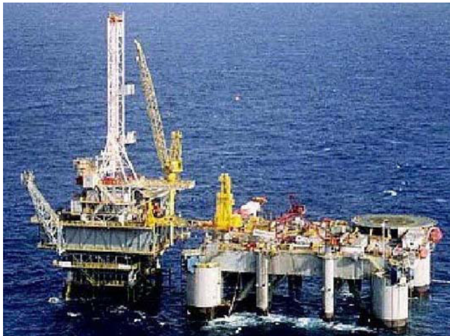
Figura 2 Plataforma fija con Floating Drilling Tender
