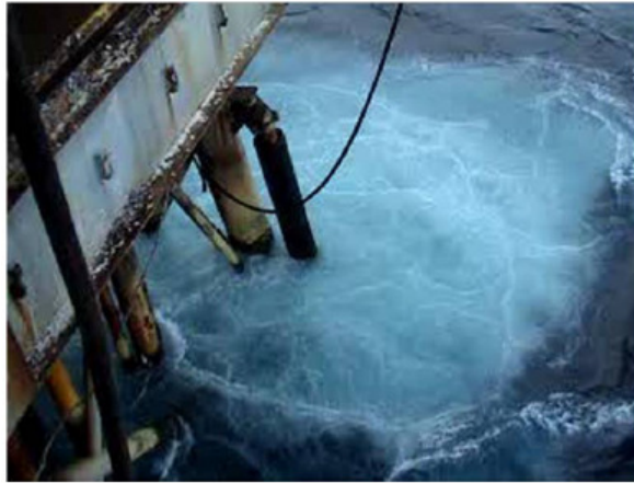
Figura 63 Salida incontrolada de gas por medio de canales como una falla.
